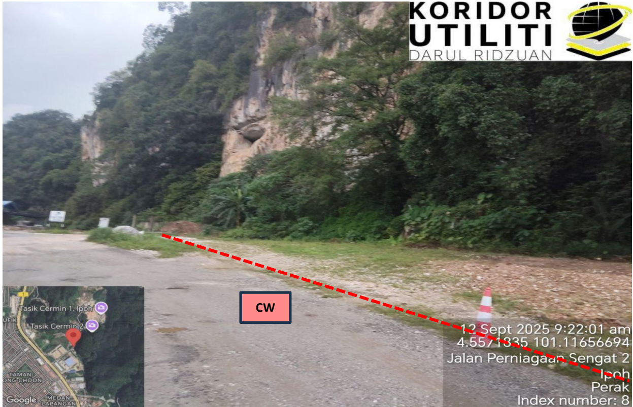
LOKASI KERJA KOREKAN TERBUKA DI JALAN PERNIAGAAN SENGAT 2
