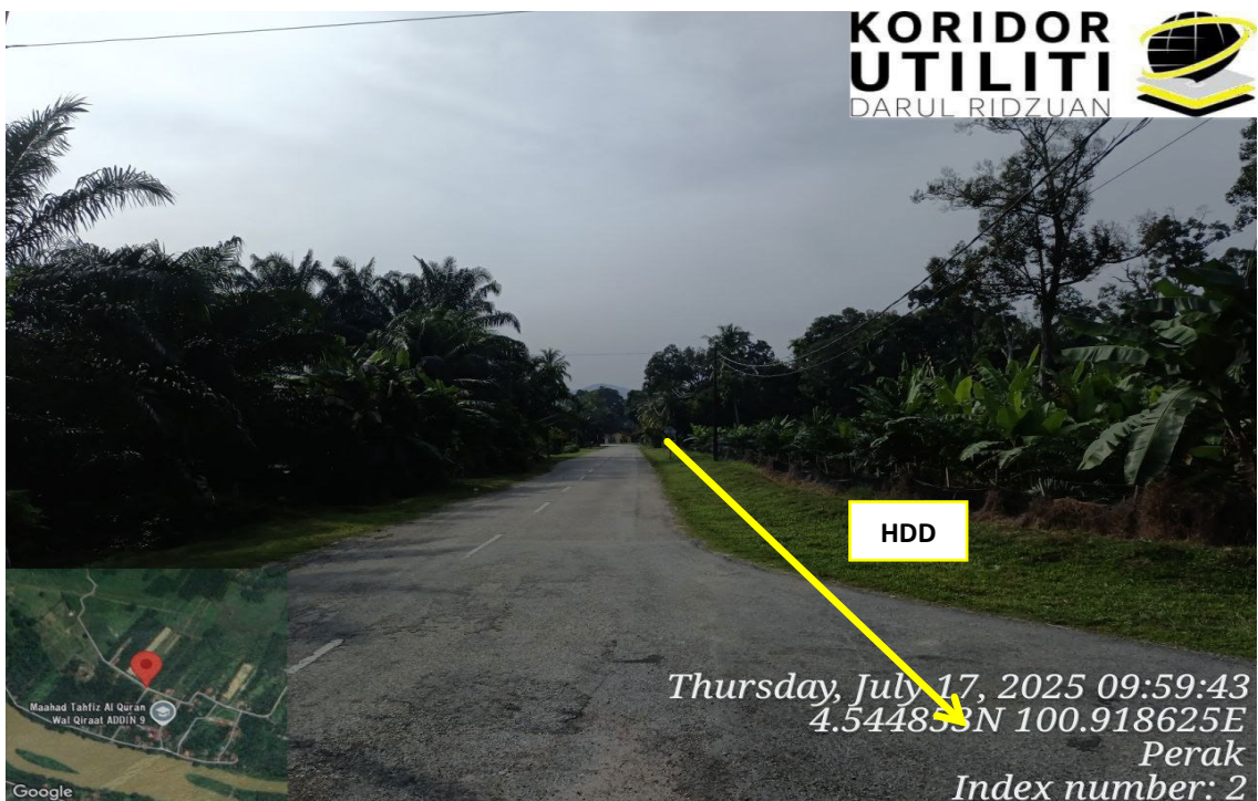
LOKASI KERJA DI JALAN CHOPIN KANAN (A203)
