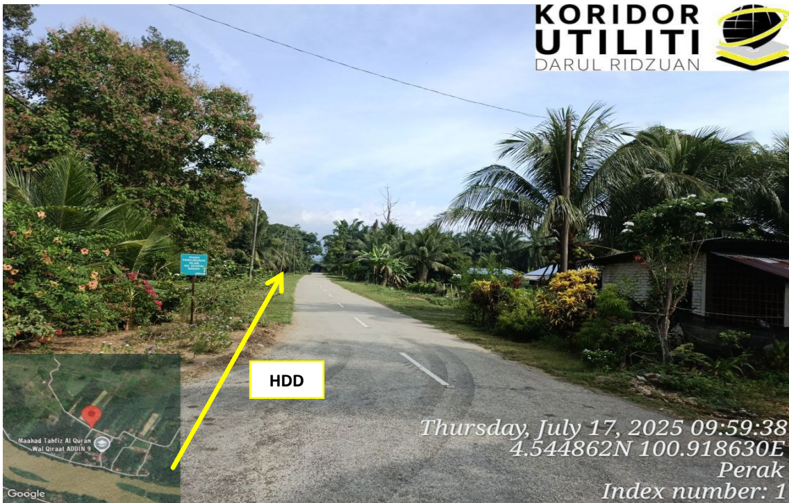
LOKASI KERJA DI JALAN CHOPIN KANAN (A203)
