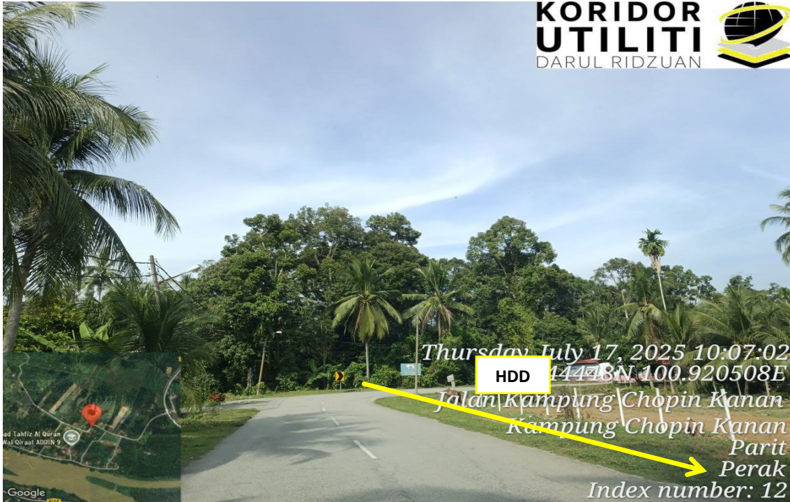
LOKASI KERJA DI JALAN CHOPIN KANAN (A203)
