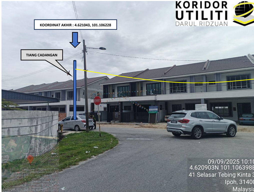
PENARIKAN KABEL DARIPADA TIANG TNB SEDIA ADA KE TIANG BARU (DI DALAM KAWASAN PEMAJU)
