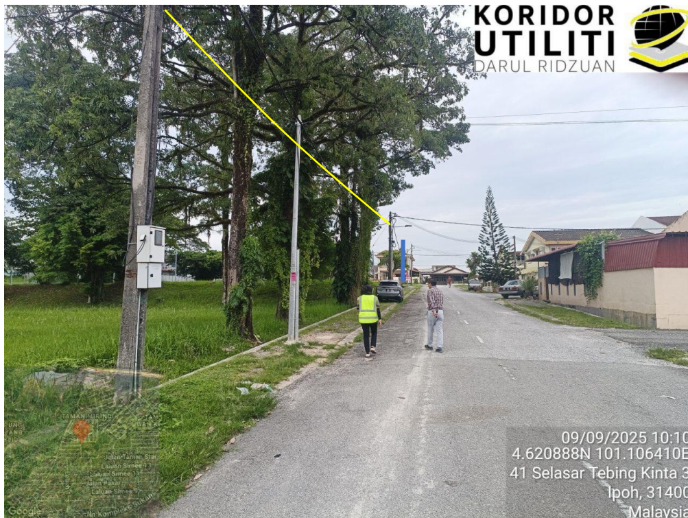
PENARIKAN KABEL DARIPADA TIANG TNB SEDIA ADA KE TIANG BARU (Sambungan akan dibuat daripada tiang elektrik TNB sediaada)
