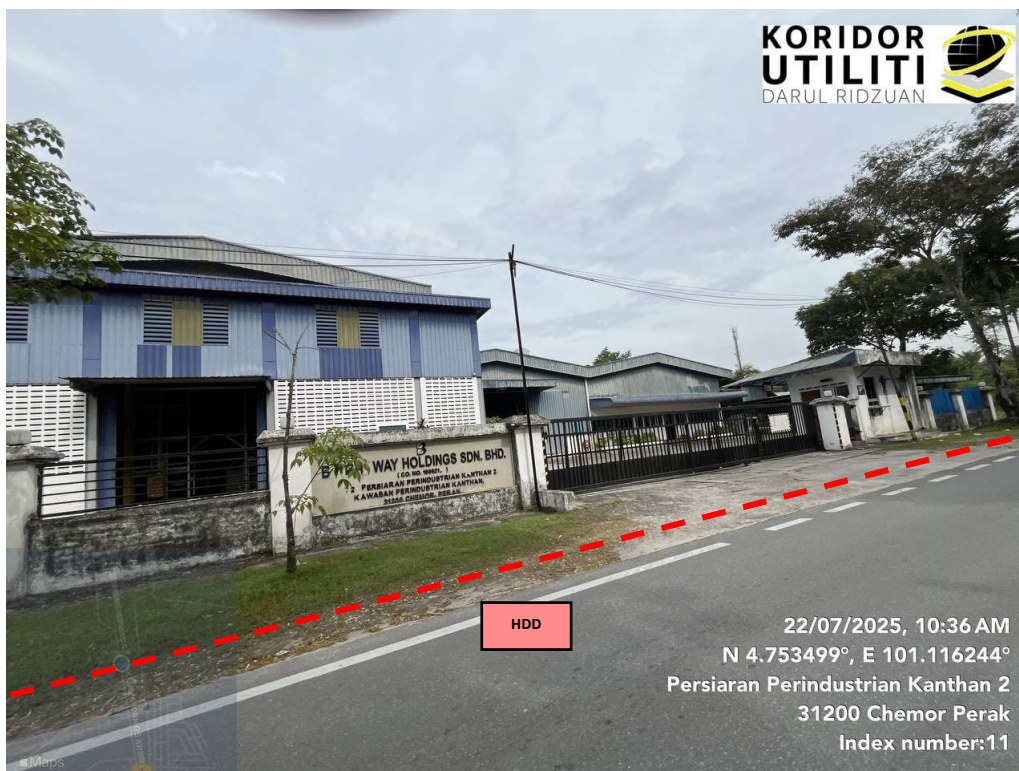
JAJARAN KERJA HDD DI PERSIARAN PERINDUSTRIAN KANTHAN 2 (Sambungan akan dibuat daripada Existing Pit ke New Pit)
