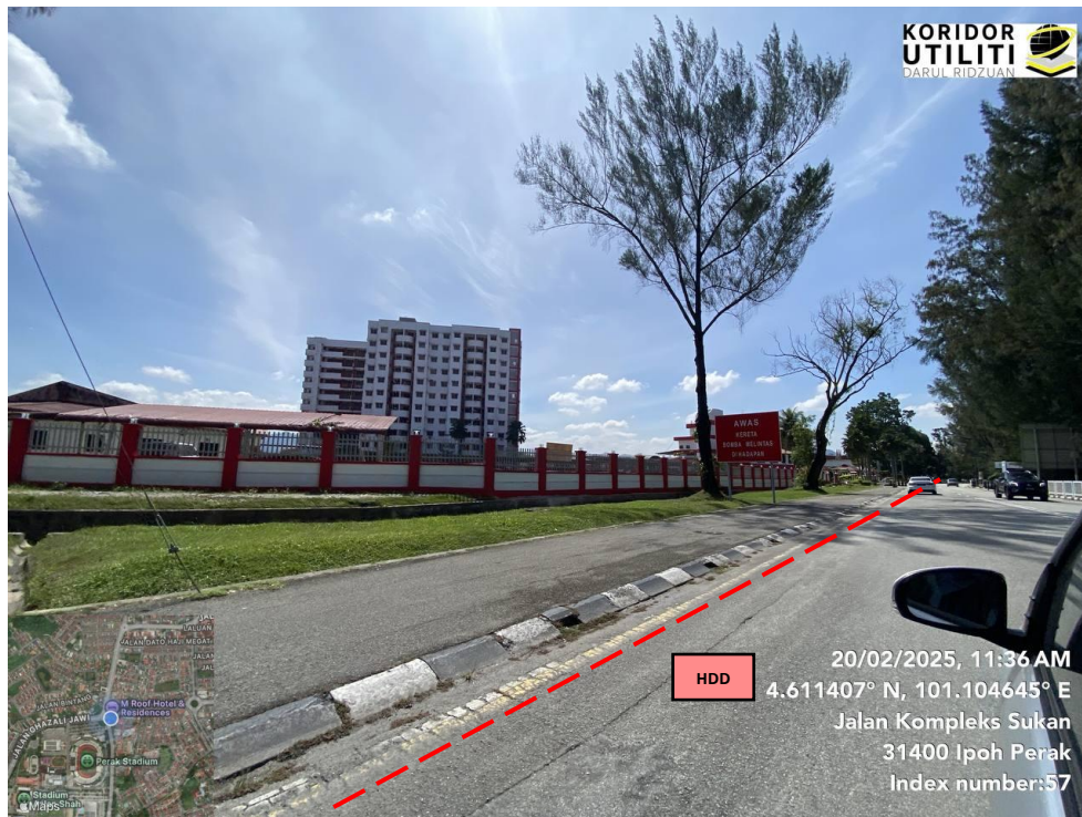
JAJARAN KERJA HDD DI JALAN KOMPLEKS SUKAN
