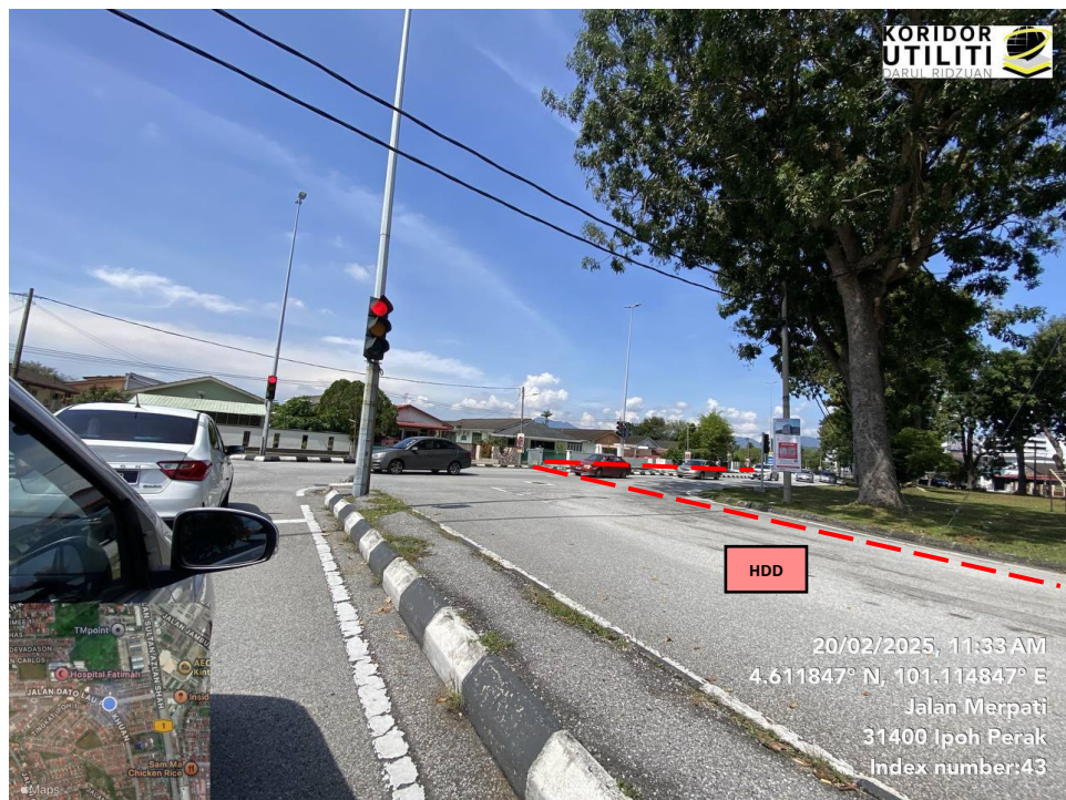
JAJARAN KERJA HDD DI JALAN MERPATI – JALAN DATO LAU PAK KHUAN
