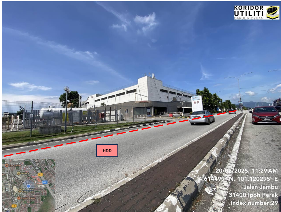
AJARAN KERJA HDD DI JALAN JAMBU
