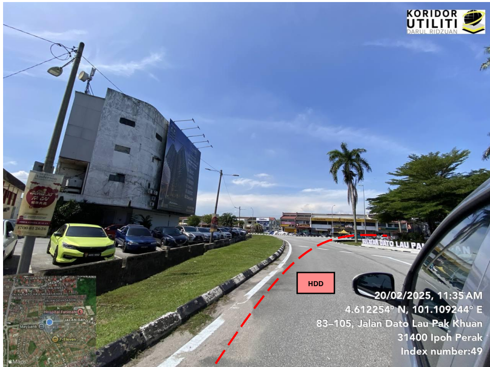
JAJARAN KERJA HDD DI JALAN DATO LAU PAK KHUAN
