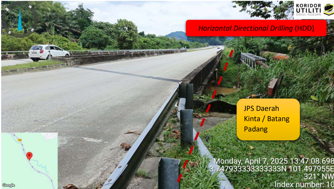
RAJAH 5 : KAEDAH HDD
