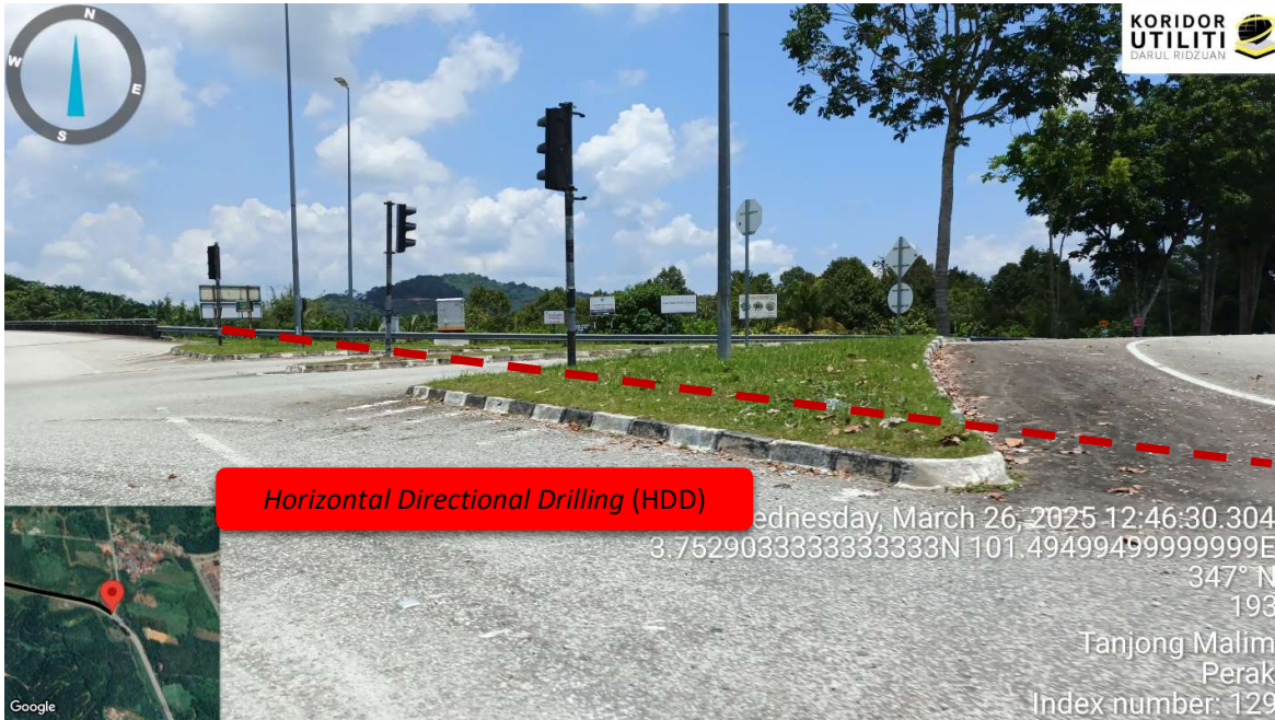
RAJAH 9 : KAEDAH HDD
