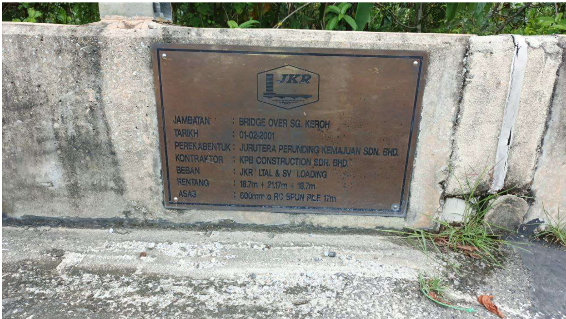
RAJAH 6 : JAMBATAN 'BRIDGE OVER SG. KEROH'
