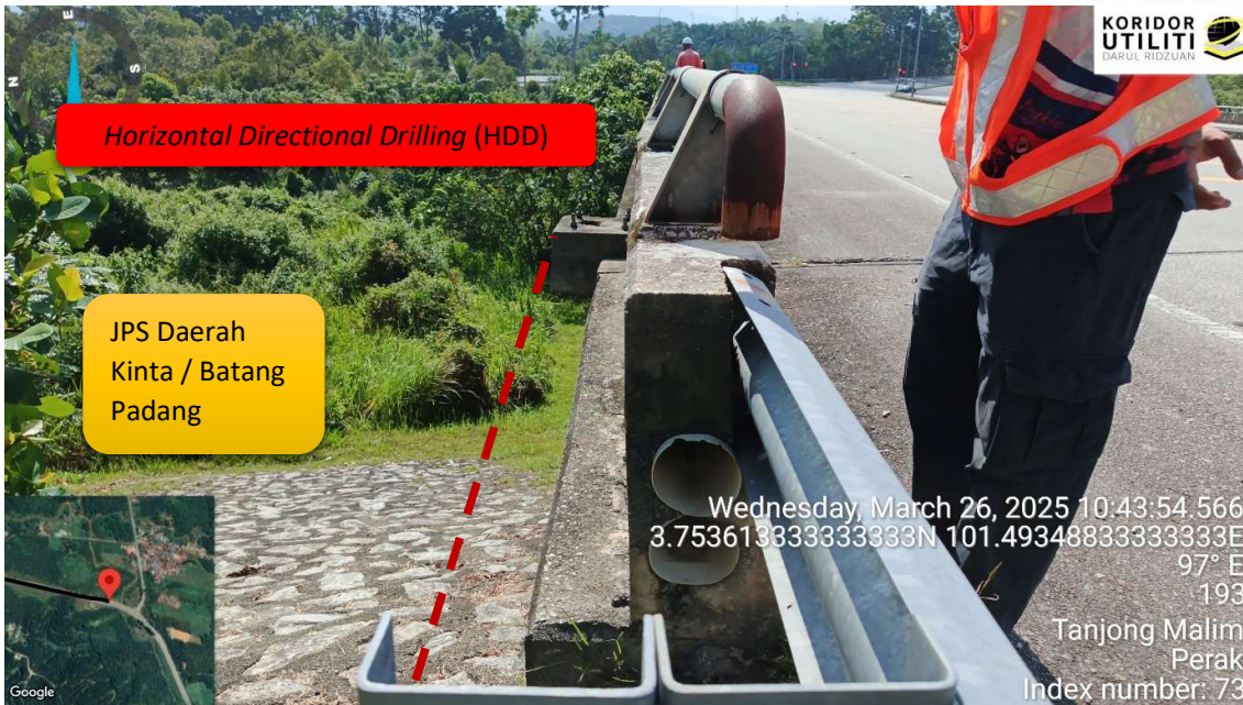
RAJAH 11 : KAEDAH HDD
