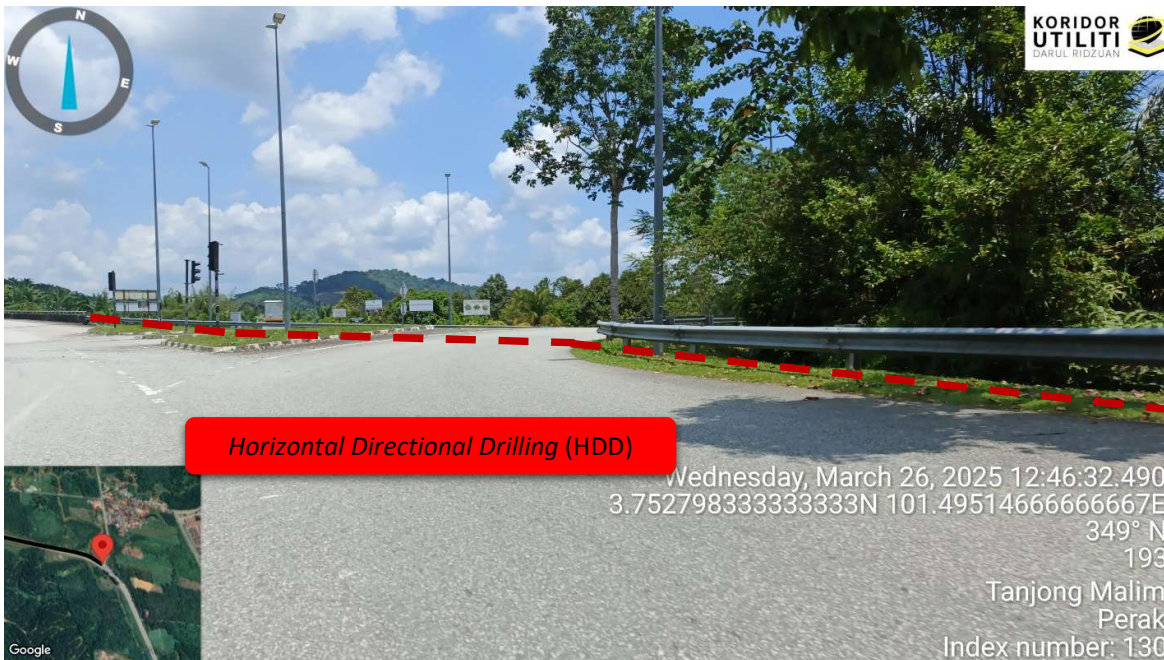
RAJAH 8 : KAEDAH HDD
