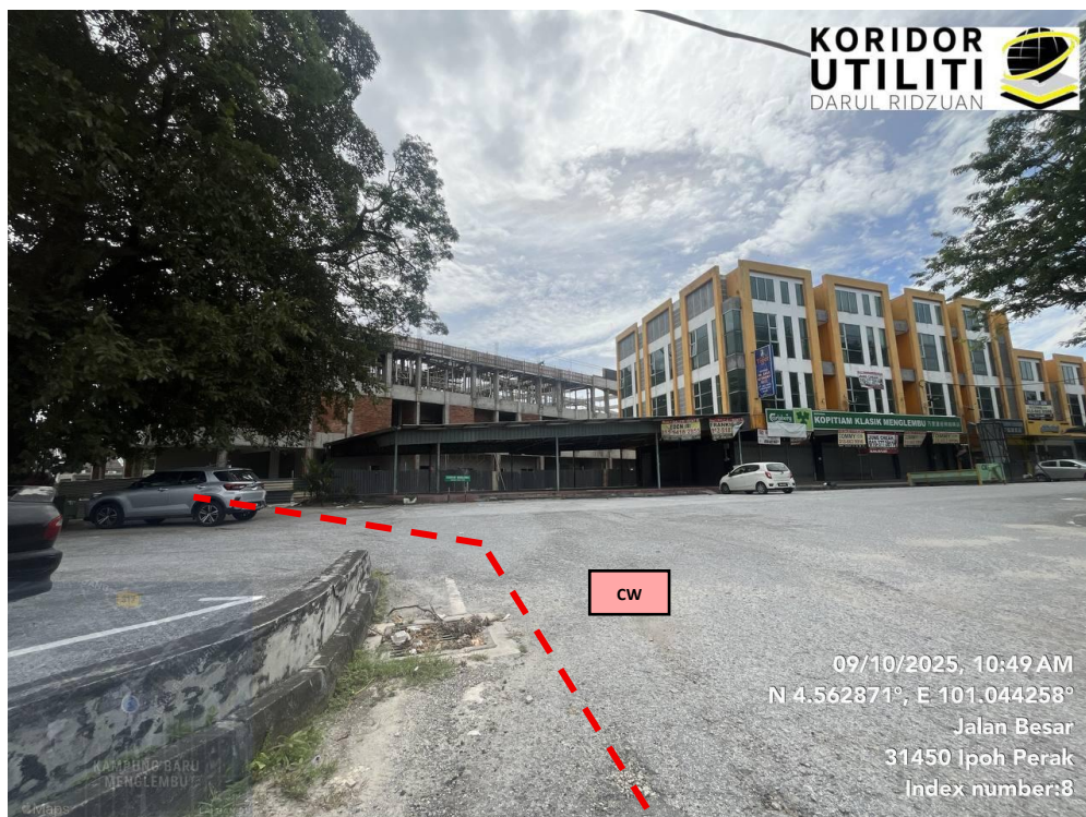
JAJARAN KOREKAN TERBUKA DI JALAN BESAR
