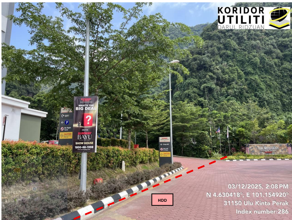
JAJARAN KERJA HDD DI JALAN SUNWAY ONSEN 1
