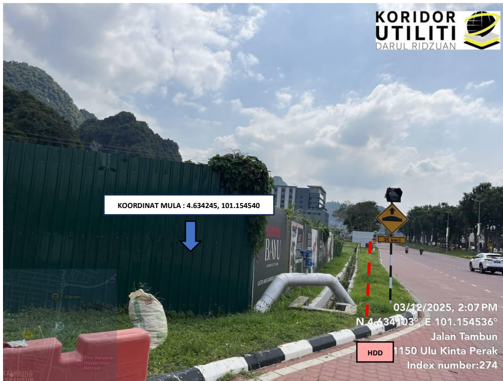
LOKASI KOORDINAT MULA KERJA HDD DI JALAN TAMBUN
