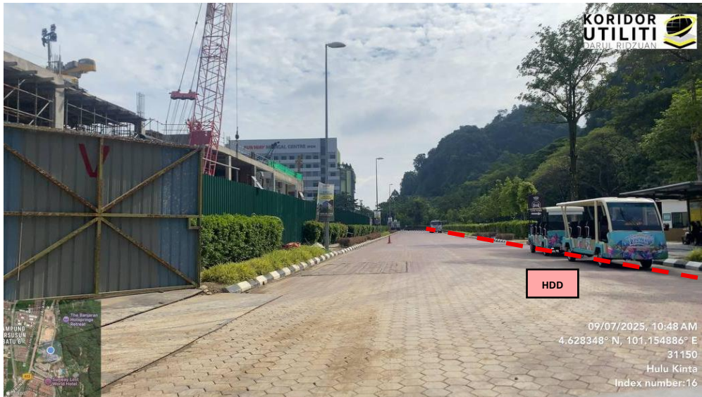
JAJARAN KERJA HDD DI JALAN SUNWAY ONSEN 2
