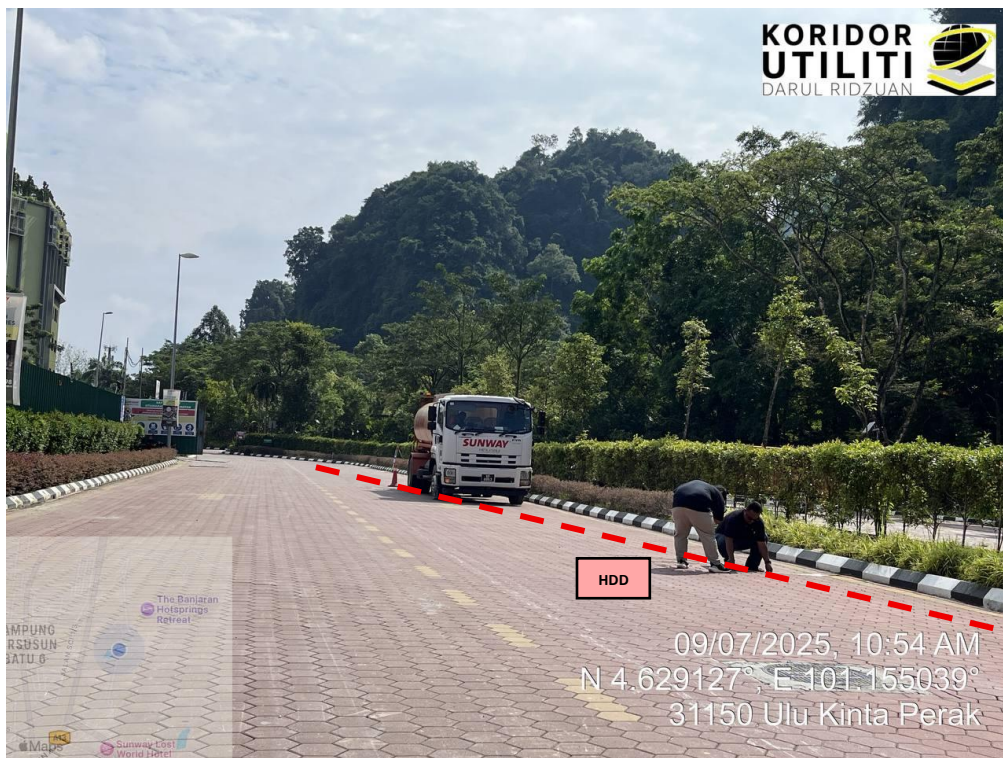
JAJARAN KERJA HDD DI JALAN SUNWAY ONSEN 1
