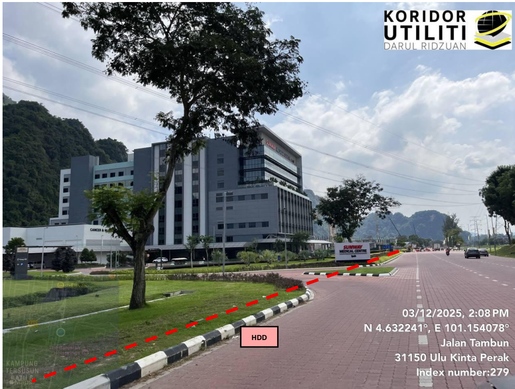
JAJARAN KERJA HDD DI JALAN TAMBUN
