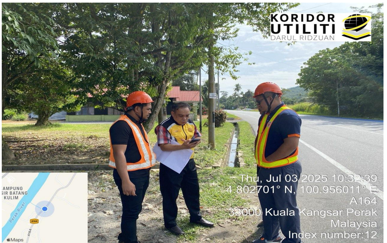
LOKASI DI JALAN JAMBATAN ISKANDAR-SAYONG-TANJUNG BELANJA (A164)
