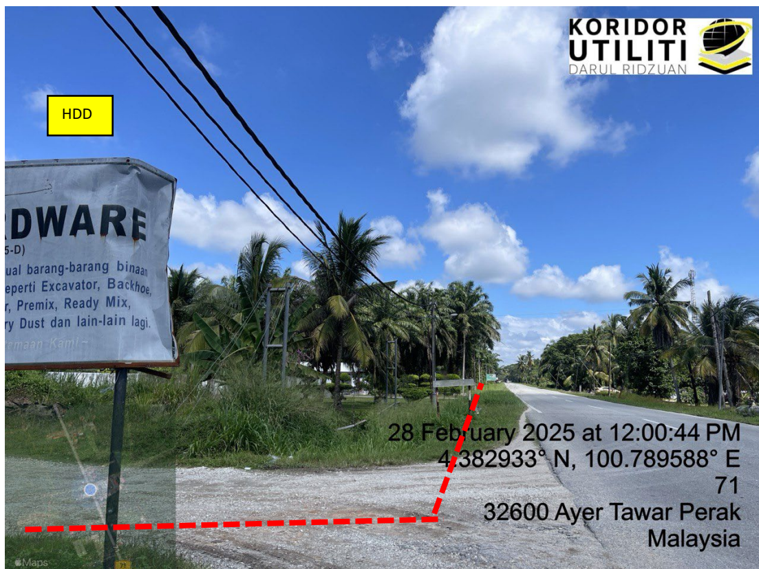
LOKASI DI JALAN BERUAS – AIR TAWAR
