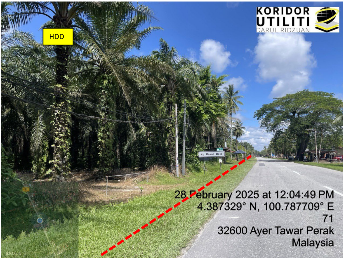
LOKASI DI JALAN BERUAS – AIR TAWAR
