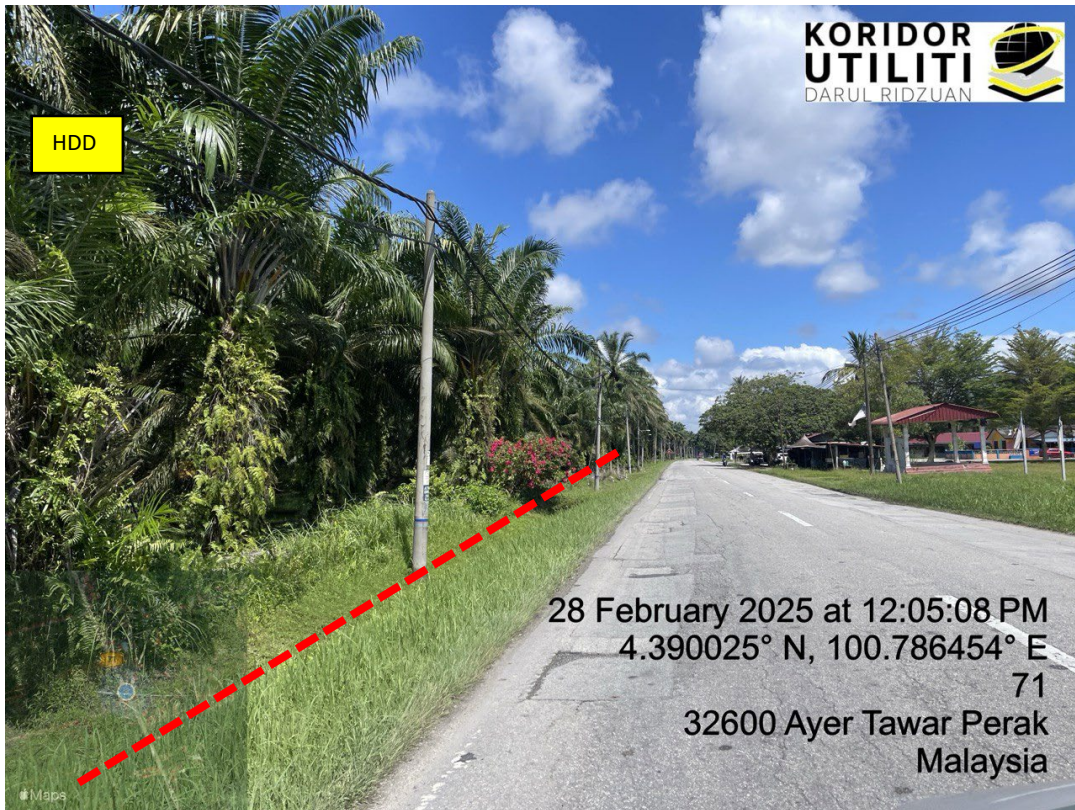
LOKASI DI JALAN BERUAS- AIR TAWAR
