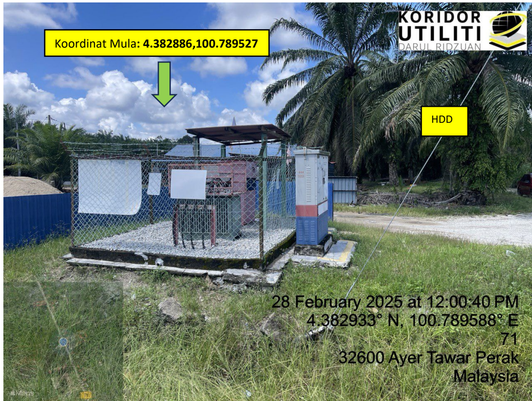
LOKASI DI JALAN BERUAS – AIR TAWAR
