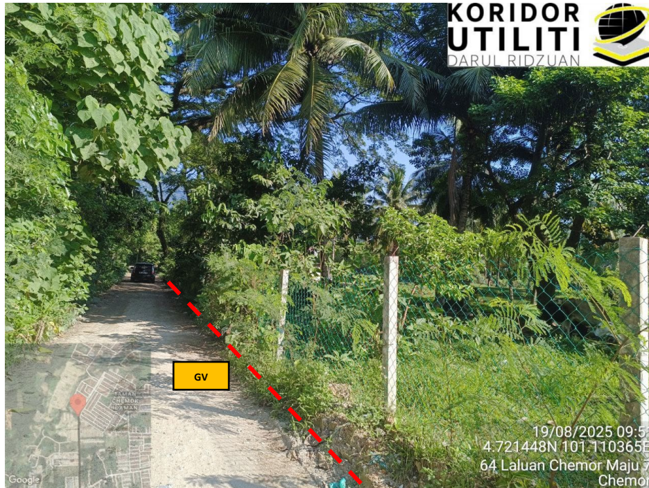
JAJARAN KOREKAN TERBUKA DI JALAN SERVIS OFF CHEMOR
