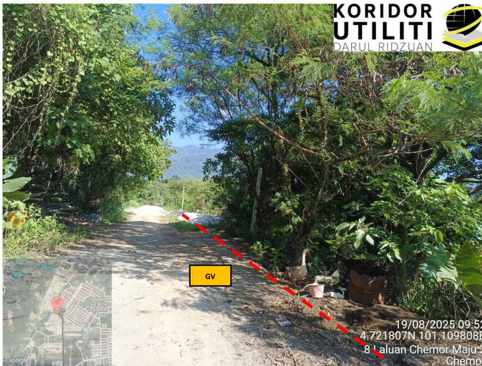
JAJARAN KOREKAN TERBUKA DI JALAN SERVIS OFF CHEMOR
