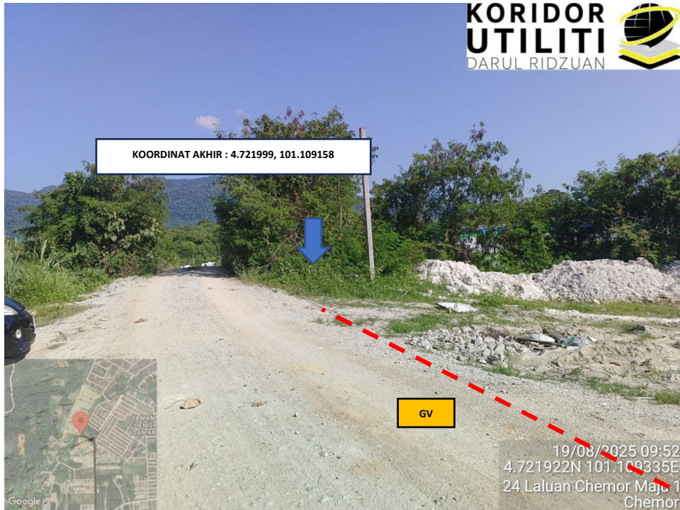
LOKASI KOORDINAT AKHIR KOREKAN TERBUKA DI JALAN SERVIS OFF CHEMOR
