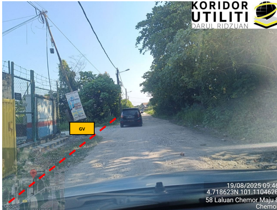
AJARAN KOREKAN TERBUKA DI JALAN SERVIS OFF CHEMOR
