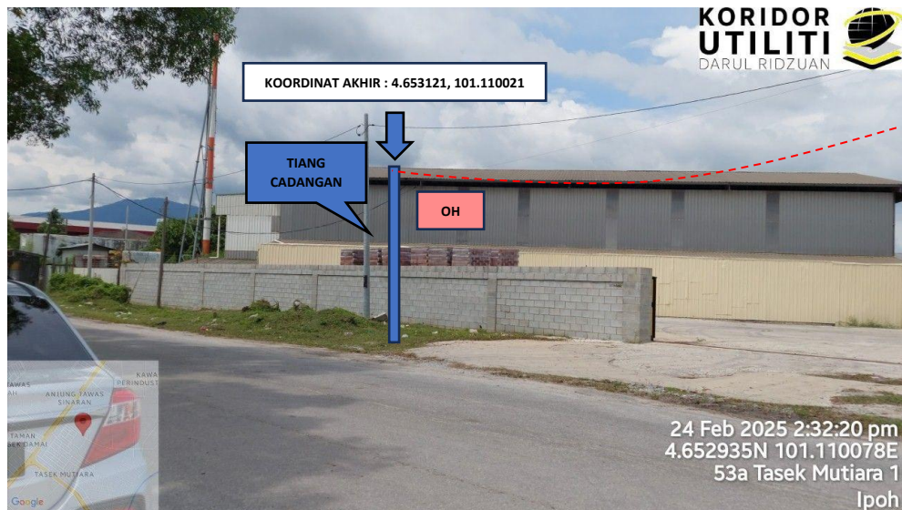
LOKASI KOORDINAT AKHIR PENANAMAN TIANG DI LEBUH PERUSAHAAN KELEBANG 1 (Sambungan akan dibuat ke tiang cadangan)
