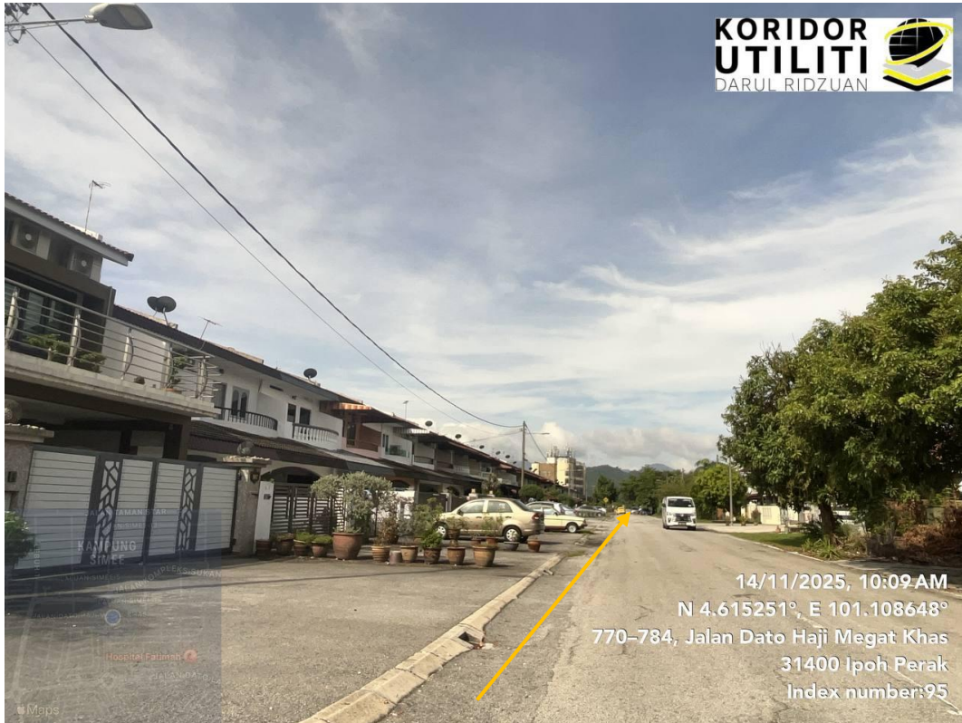
JAJARAN BAGI KERJA HDD
