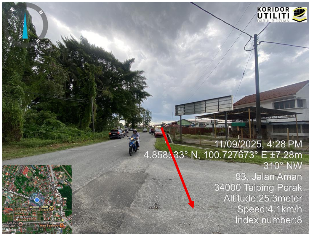
JAJARAN TIANG SEDIA ADA DI JALAN MAJLIS
