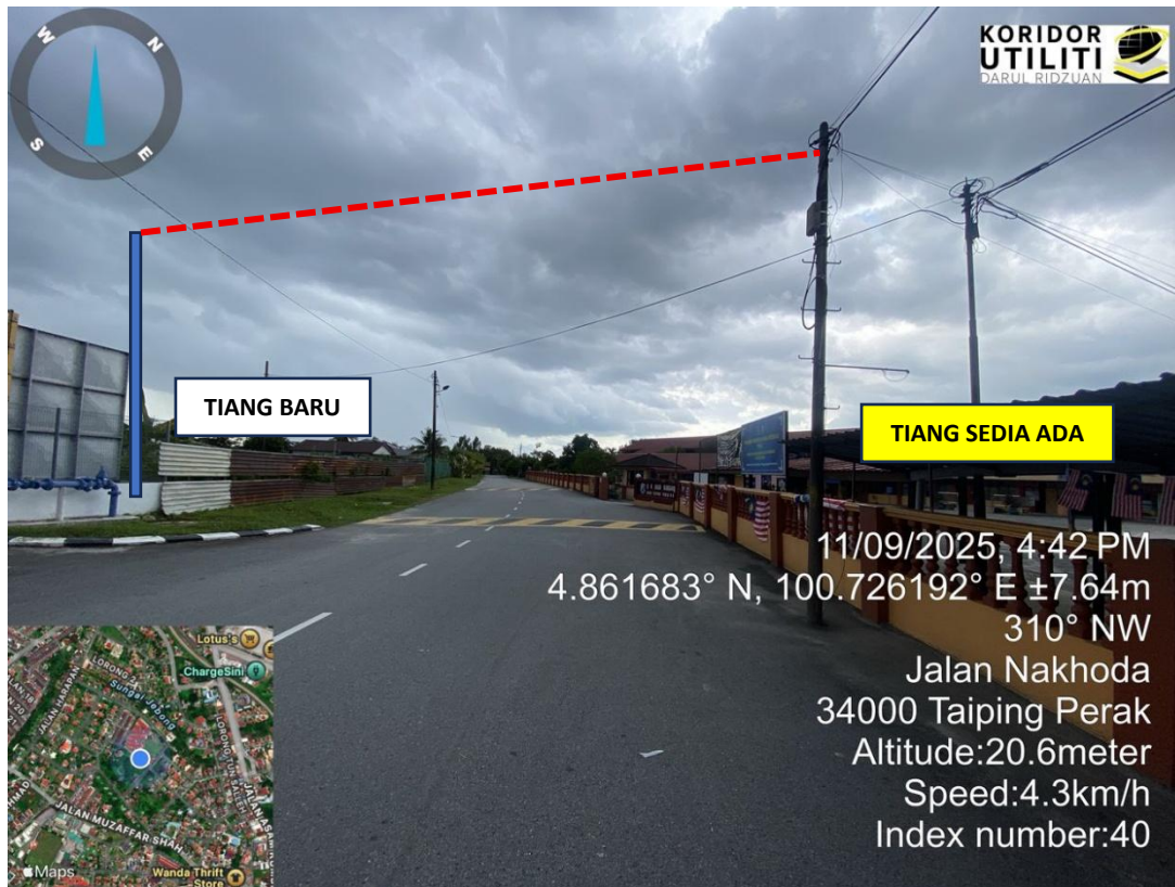
SAMBUNGAN KABEL TM DARI TIANG SEDIA ADA KE TIANG BARU MENGGUNAKAN KAEDAH OVERHEAD (OH)
