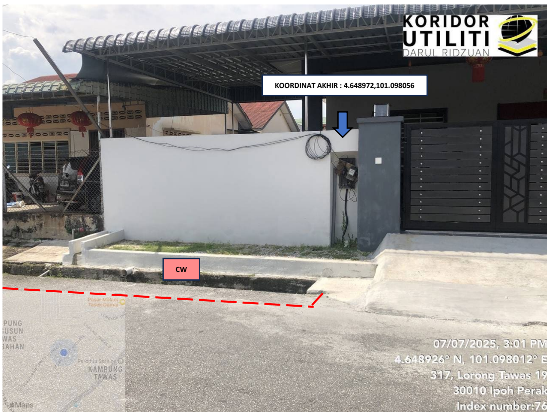
JAJARAN KOREKAN TERBUKA DI LORONG TAWAS 19 (Sambungan akan dibuat ke tiang TNB sedia ada)
