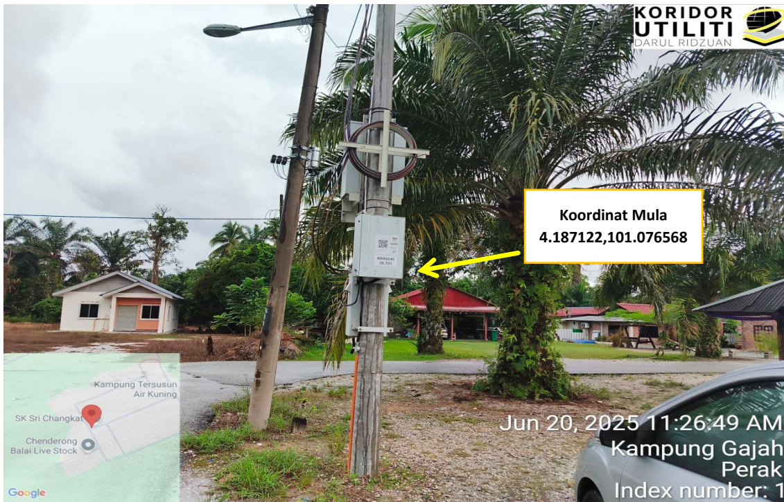
LOKASI KERJA DI KG AIR KUNING
