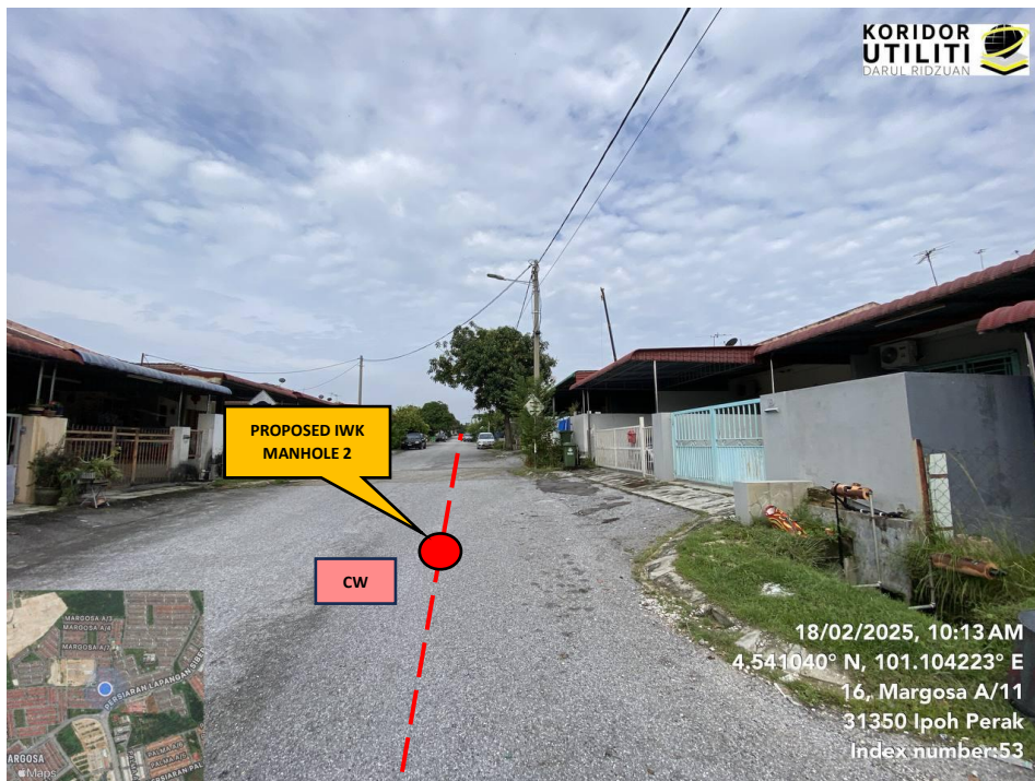
JAJARAN KOREKAN TERBUKA DI JALAN MARGOSA A/11 (Lokasi manhole cadangan 2)
