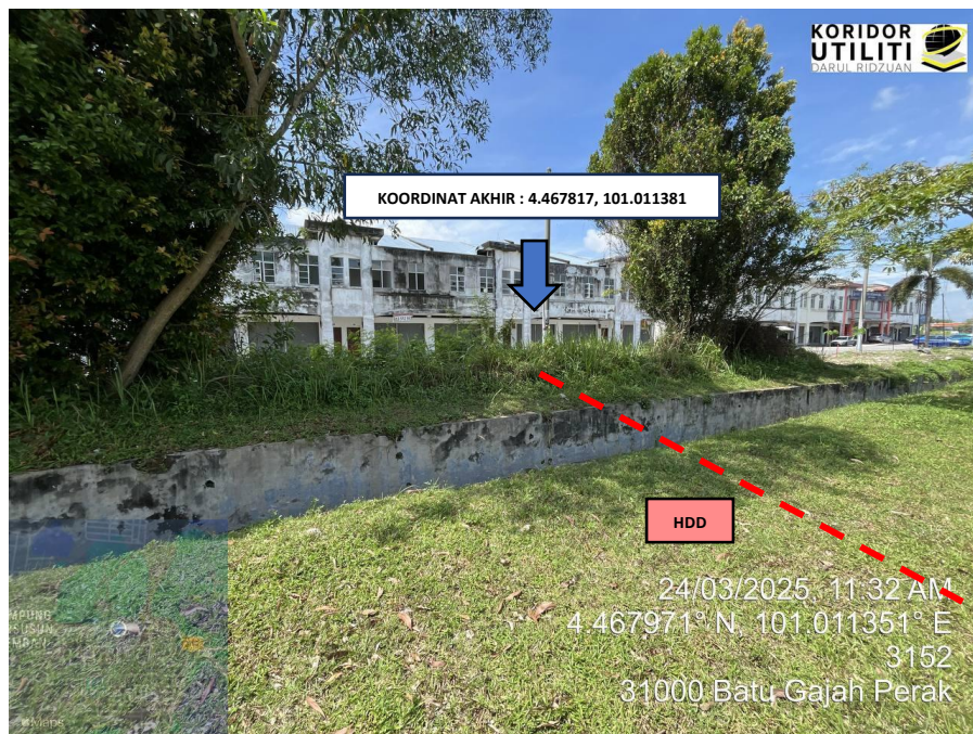
LOKASI KOORDINAT AKHIR KERJA HDD DI JALAN BEMBAN
