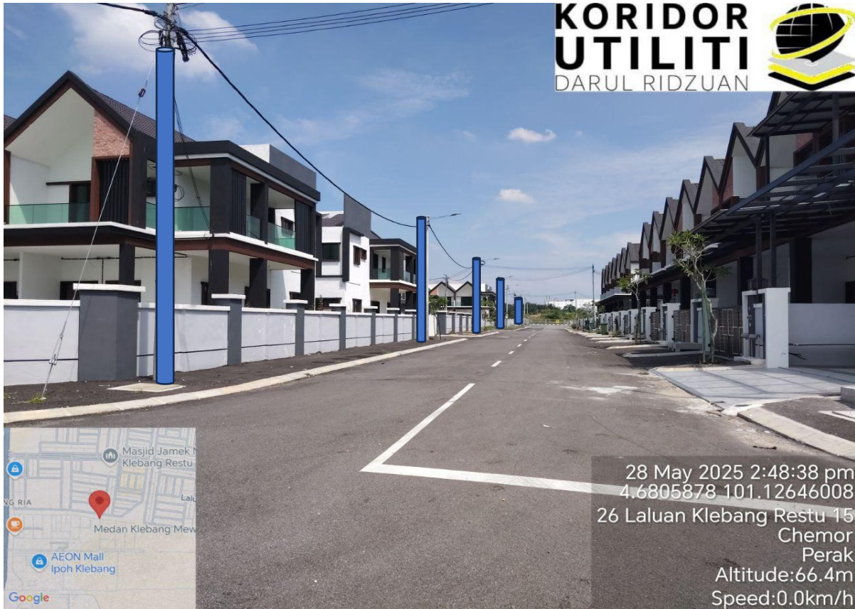
LOKASI KERJA PENANAMAN TIANG DI TAMAN KLEBANG PERDANA
