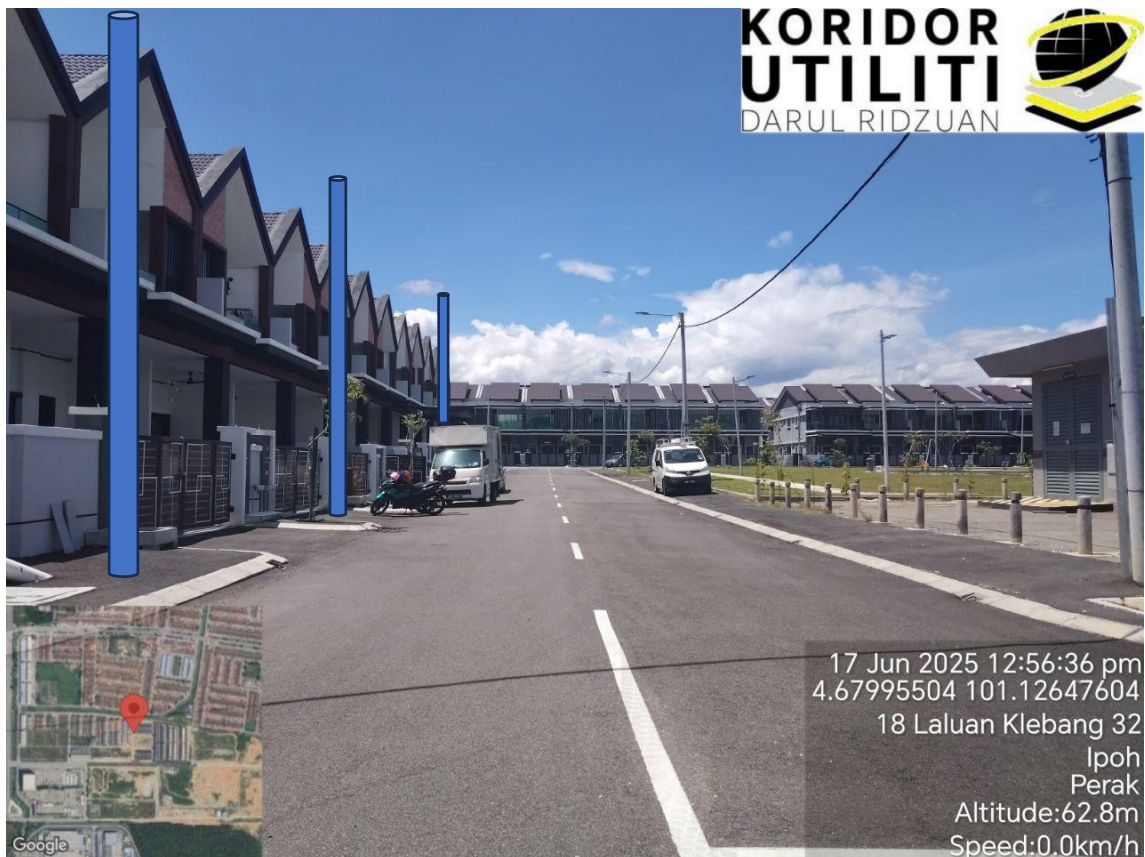
LOKASI KERJA PENANAMAN TIANG DI LALUAN KLEBANG 32
