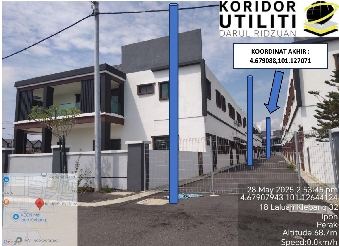
LOKASI KOORDINAT A AKHIR KERJA PENANAMAN TIANG DI LALUAN KLEBANG 32
