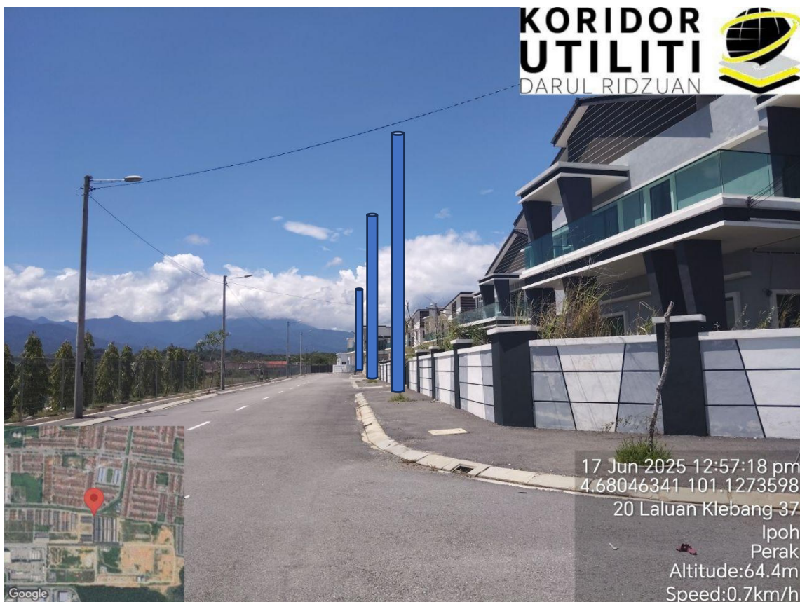
LOKASI KERJA PENANAMAN TIANG DI LALUAN KLEBANG 37
