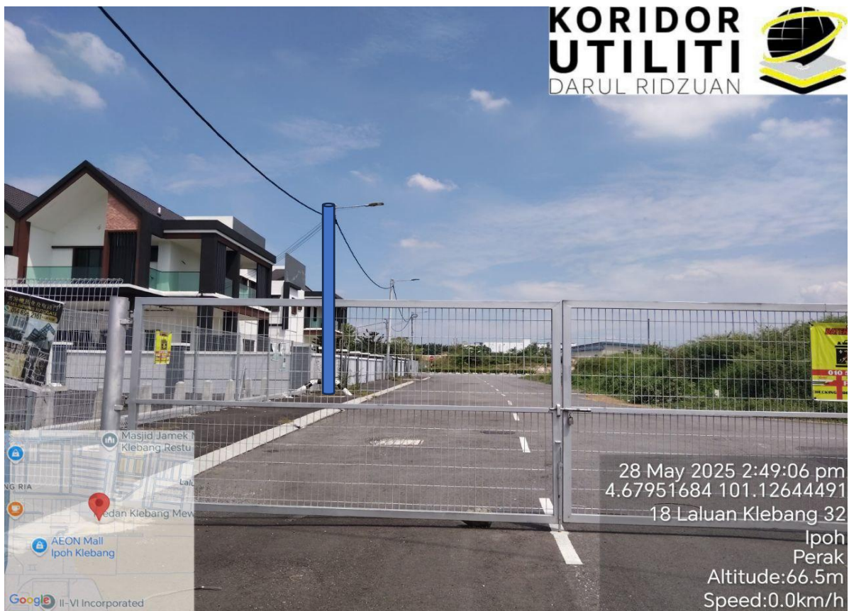
LOKASI KERJA PENANAMAN TIANG DI LALUAN KLEBANG 32
