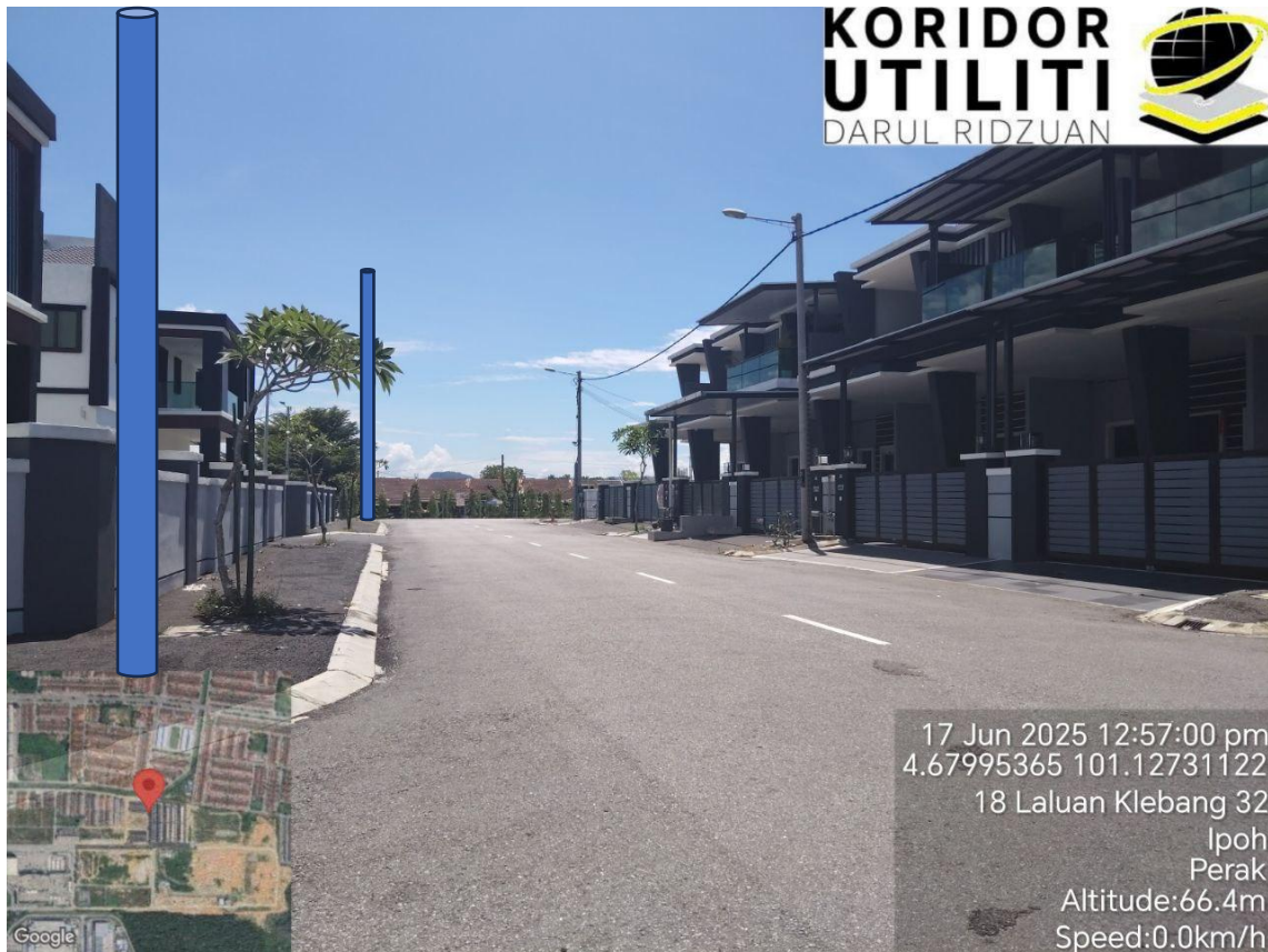
LOKASI KERJA PENANAMAN TIANG DI LALUAN KLEBANG 32
