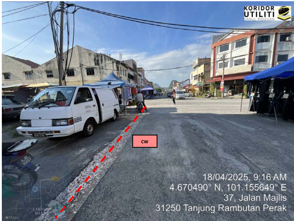
JAJARAN KOREKAN TERBUKA DI JALAN MAJLIS
