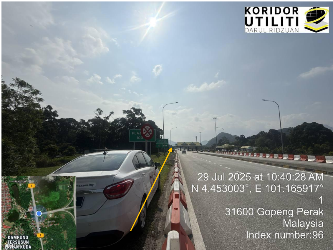
HDD KE MANHOLE SEDIA ADA DI KAWASAN PLUS
