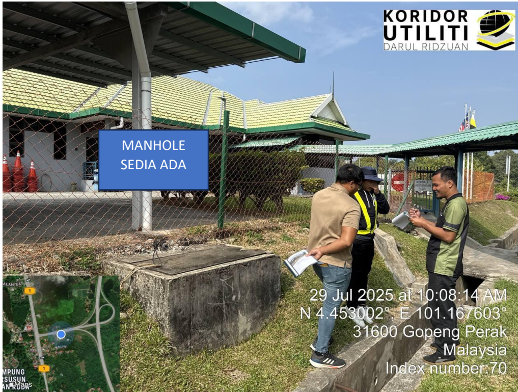
KEDUDUKAN MANHOLE SEDIA ADA DI KAWASAN PLUS
