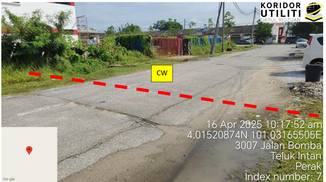
Jalan Bomba, Teluk Intan
