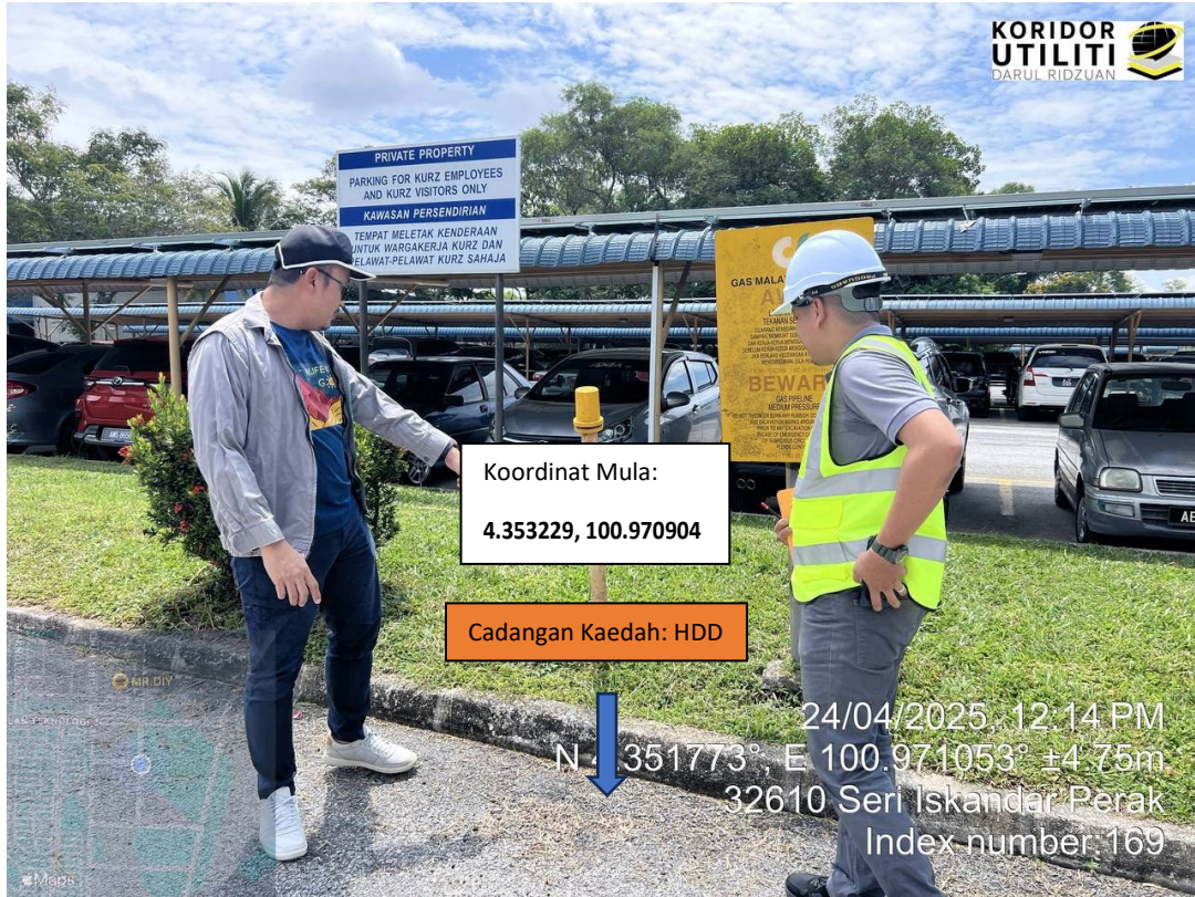
LOKASI KERJA: JALAN TEKNOLOGI 2 – (KAEDAH HDD)
