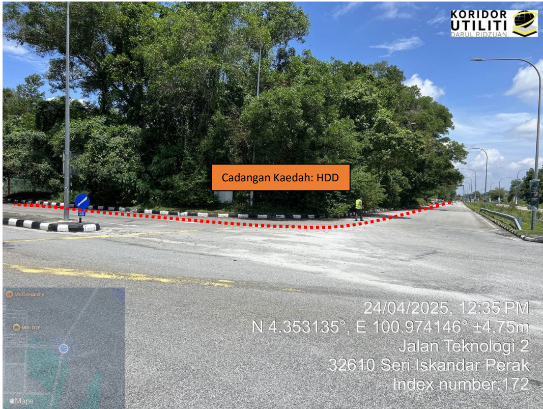
LOKASI KERJA: SELEKOH JALAN TEKNOLOGI 2 MENGHALA KE JALAN TEKNOLOGI 9 (KAEDAH HDD)
