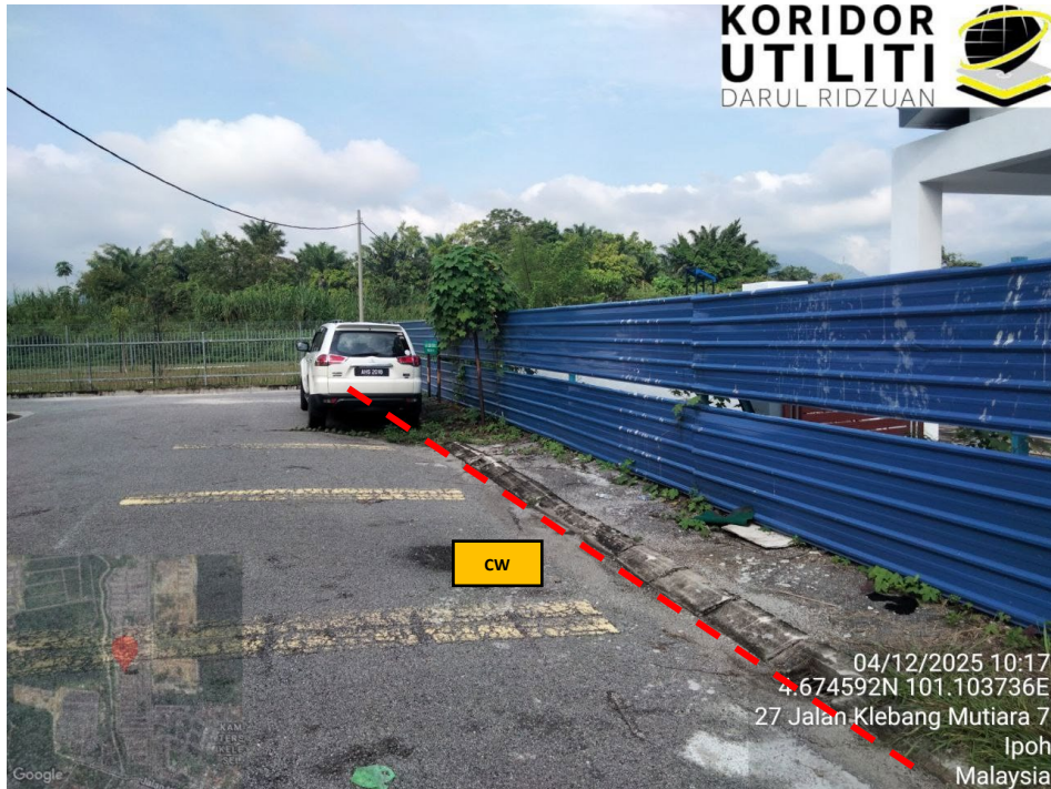
JAJARAN KOREKAN TERBUKA DI JALAN KLEBANG MUTIARA 9
