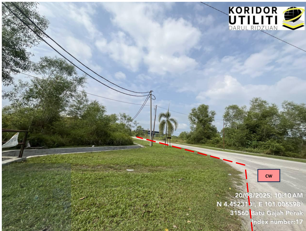
JAJARAN KOREKAN TERBUKA DI LALUAN BEMBAN 13
