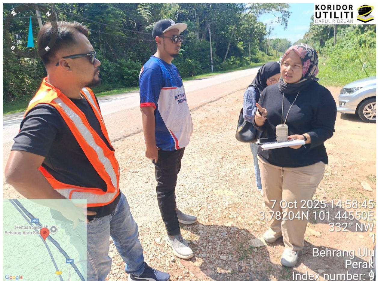
Rajah 4: Perbincangan bersama Pemohon dan Penyedia Utiliti berkenaan jajaran dan kaedah korekan
