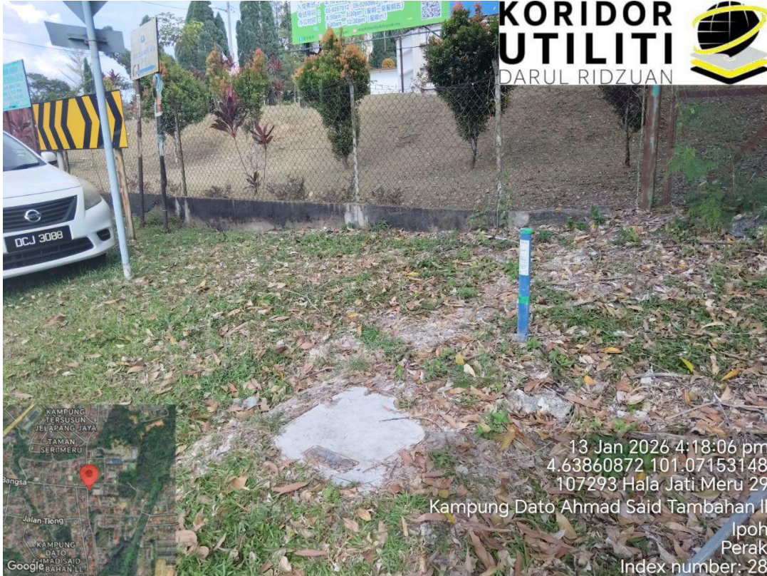
KOORDINAT AKHIR – MANHOLE SEDIA ADA MAXIS
