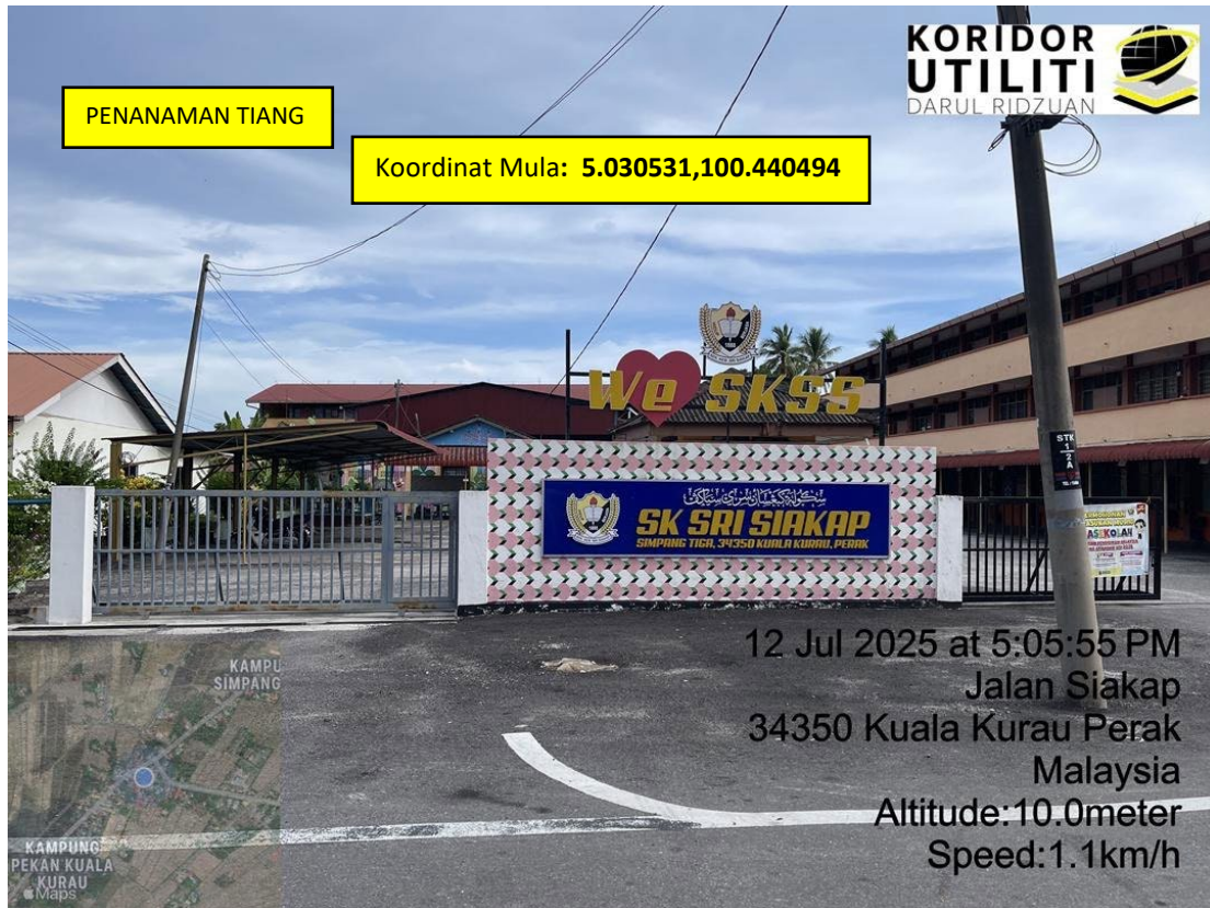
LOKASI DI JALAN BAGAN SERAI – KUALA KURAU
