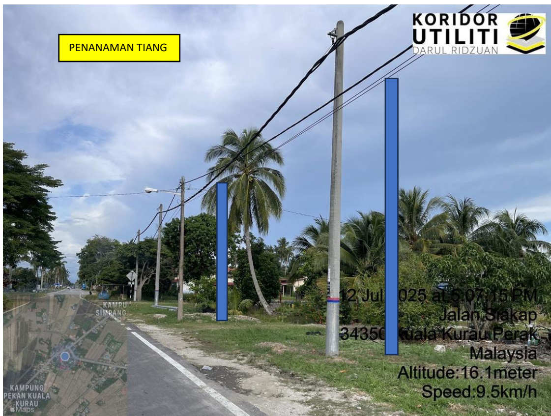
LOKASI DI JALAN BAGAN SERAI – KUALA KURAU
