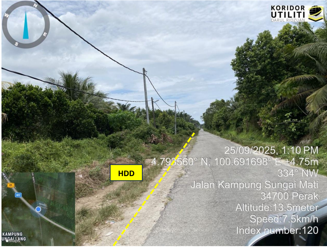
CADANGAN HDD DI JALAN KAMPUNG PERAK(PDT)
