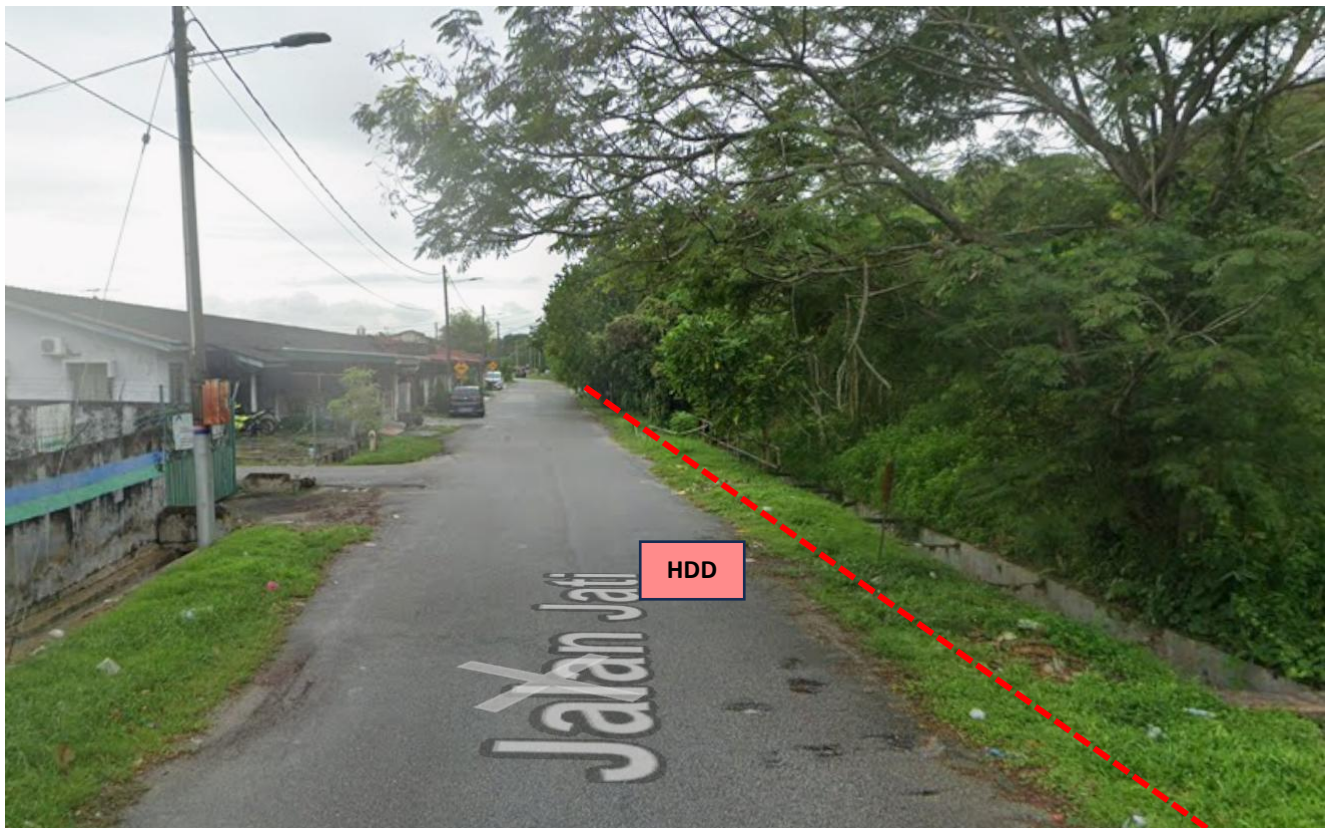
LOKASI KERJA-KERJA KOREKAN HDD DI JALAN JATI
