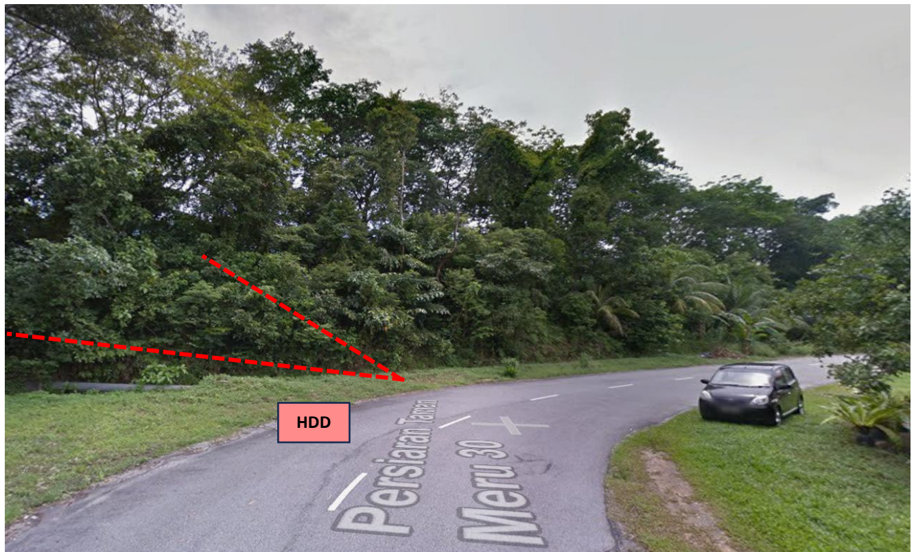
LOKASI KERJA-KERJA KOREKAN HDD DI PERSIARAN TAMAN MERU 30
