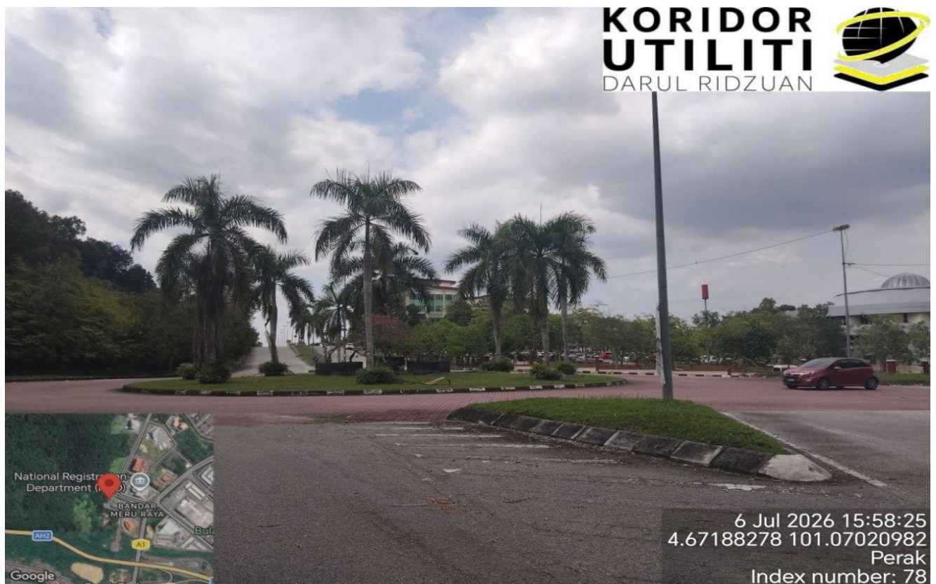
LOKASI KERJA-KERJA KOREKAN HDD DI PERSIARAN MERU UTAMA
