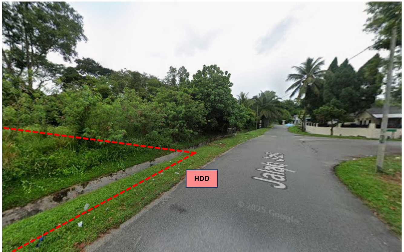
LOKASI KERJA-KERJA KOREKAN HDD DI JALAN JATI
