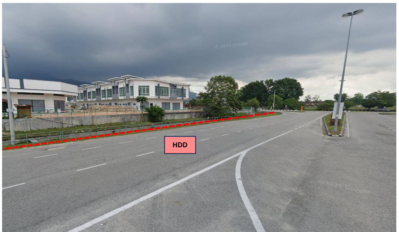
LOKASI KERJA-KERJA KOREKAN HDD DI PERSIARAN MERU RAYA 2
