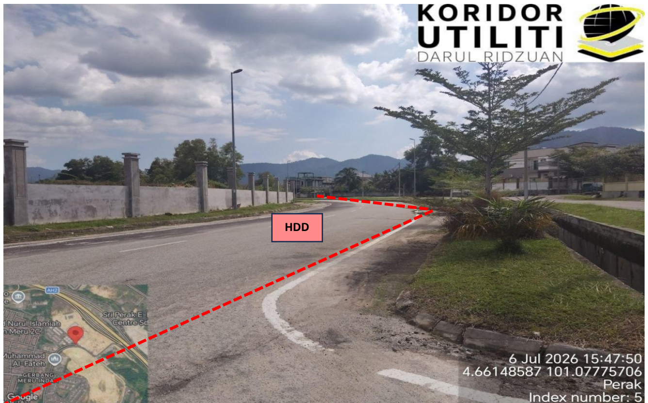
LOKASI KERJA-KERJA KOREKAN HDD DI PEKELILING MERU INDAH
