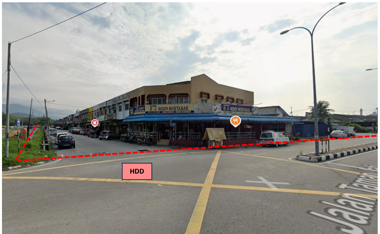
LOKASI KERJA-KERJA KOREKAN HDD DI JALAN JATI
