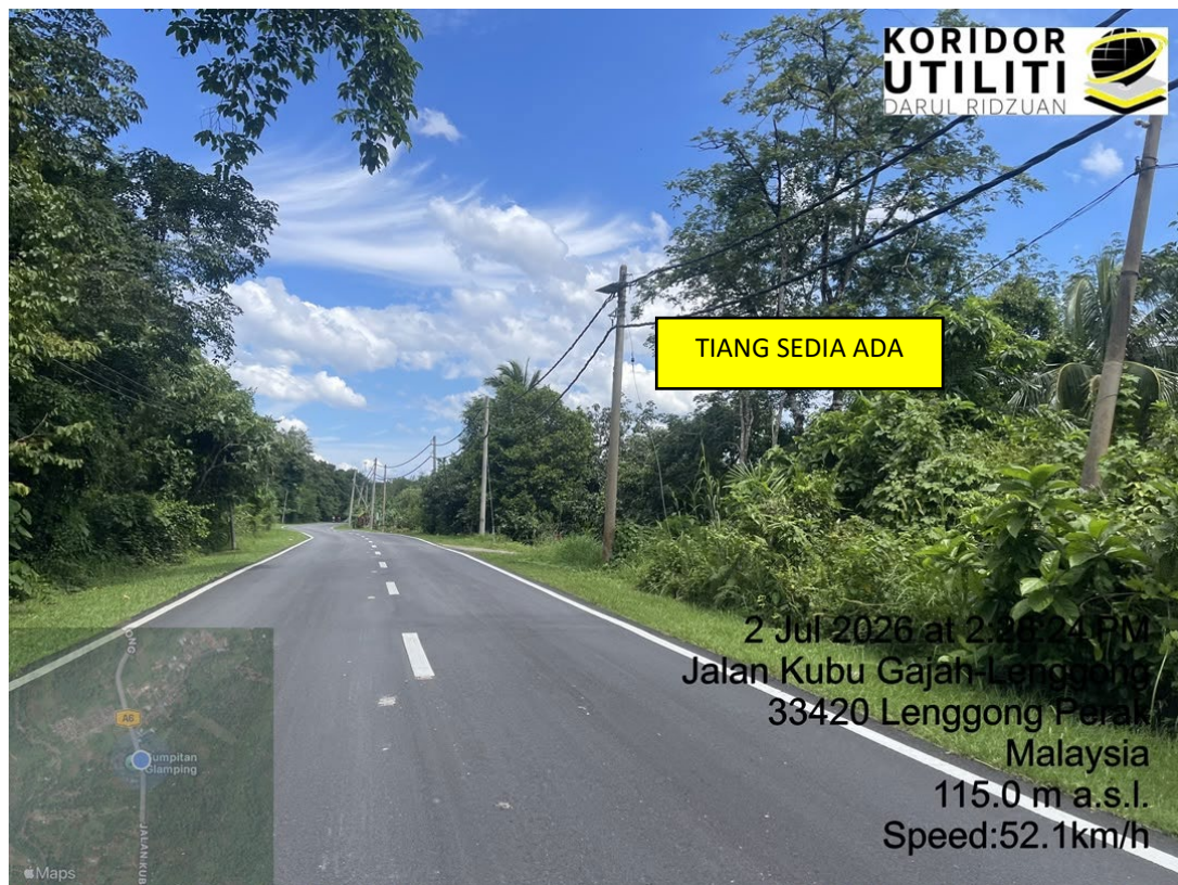
LOKASI DI JALAN SUMPITAN – IJOK
