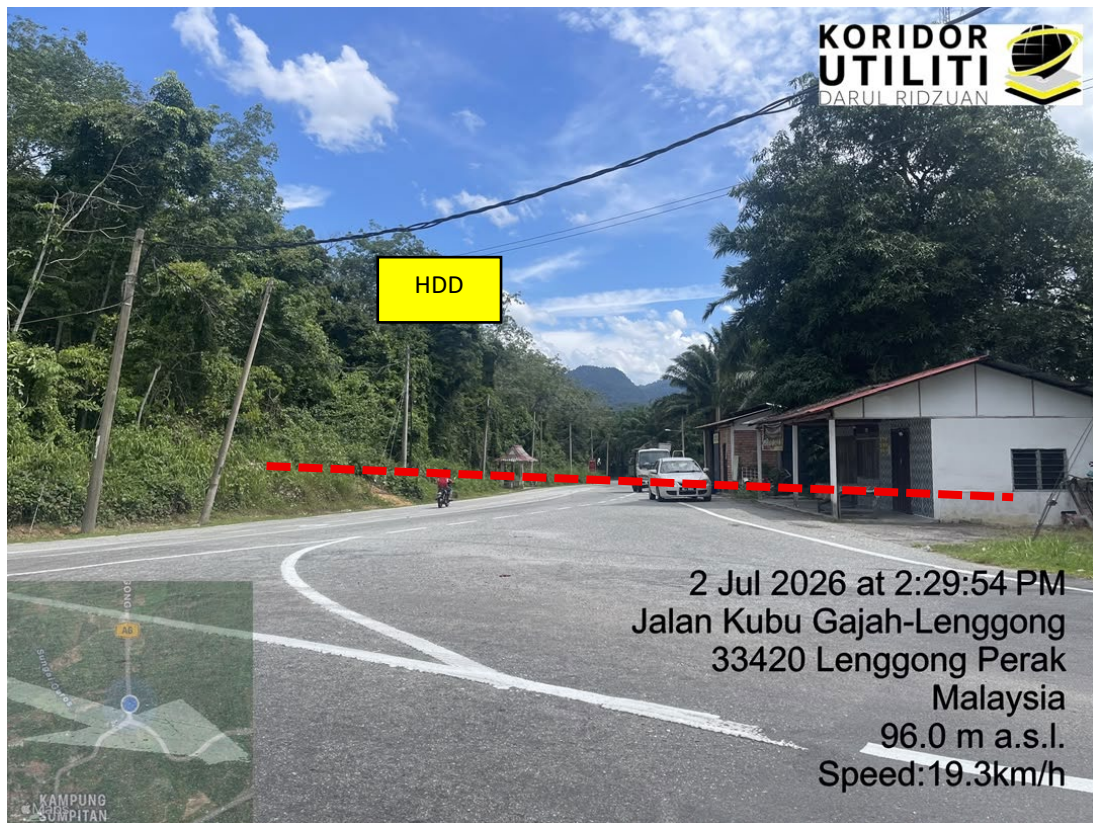
LOKASI DI JALAN SUMPITAN - IJOK
