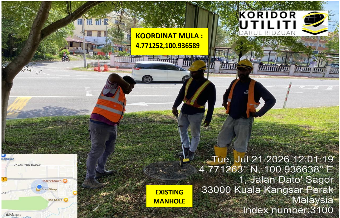
LOKASI DI EXISTING MANHOLE TIME
