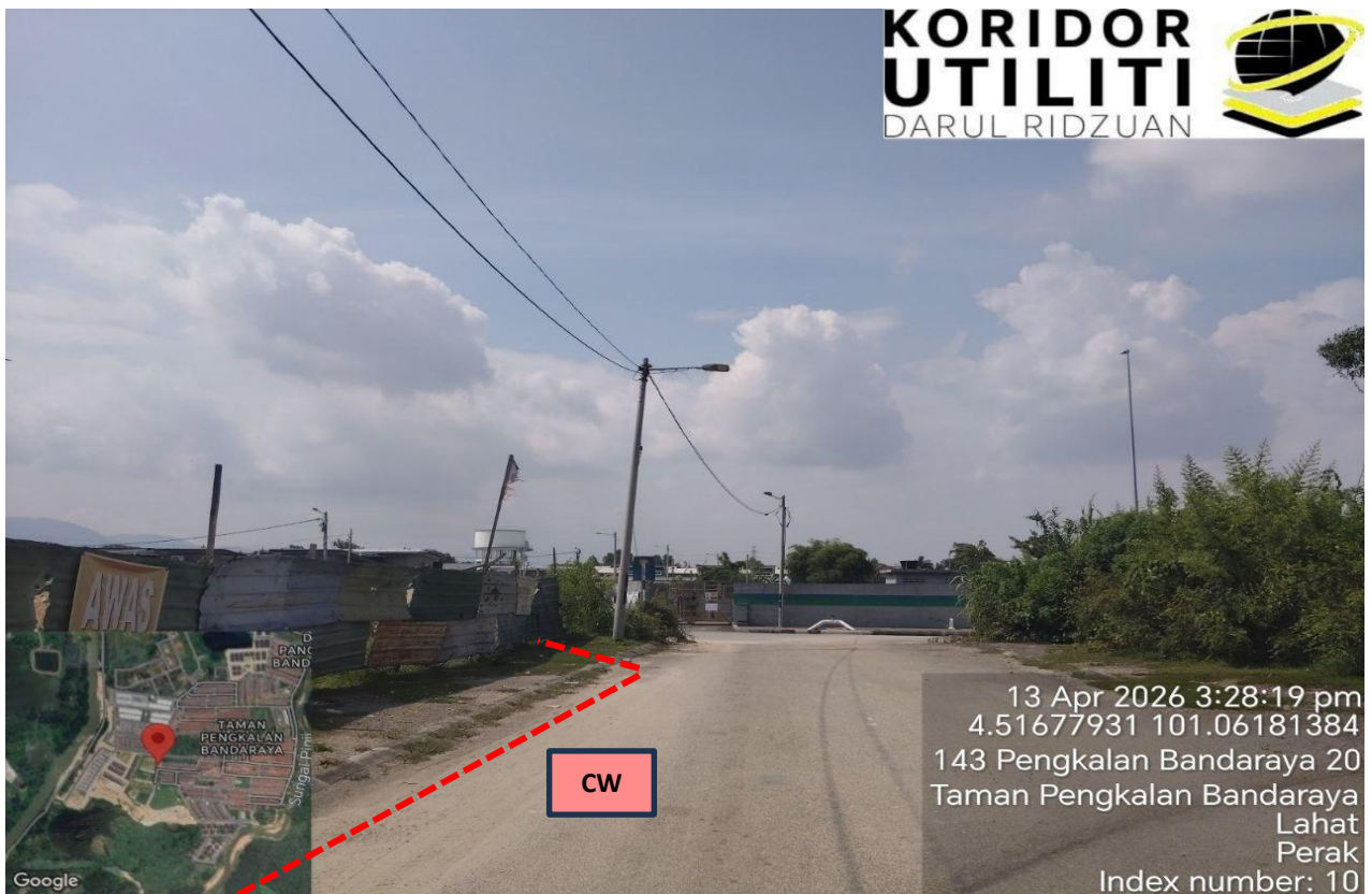
LOKASI KERJA KOREKAN TERBUKA DI PENKALAN BANDARAYA 20
