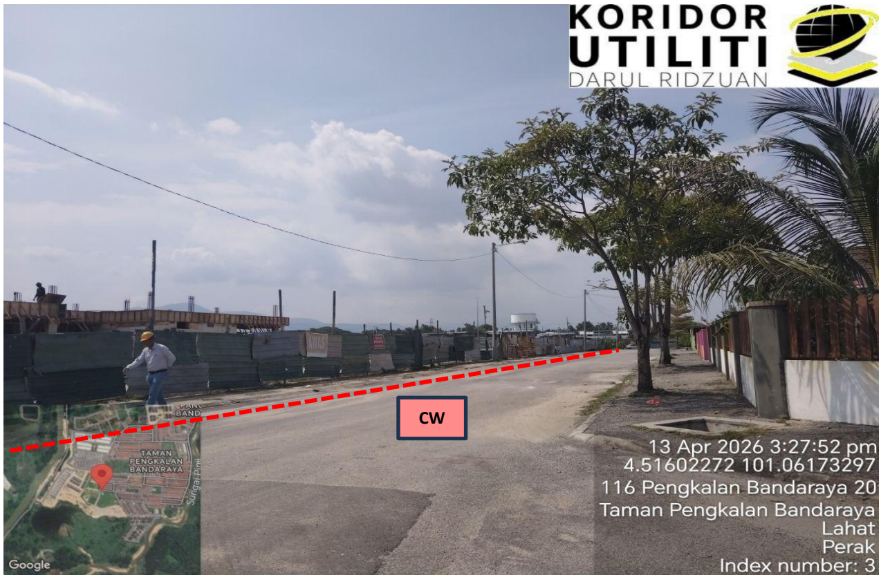
LOKASI KERJA KOREKAN TERBUKA DI PENGKALAN BANDARAYA 20
