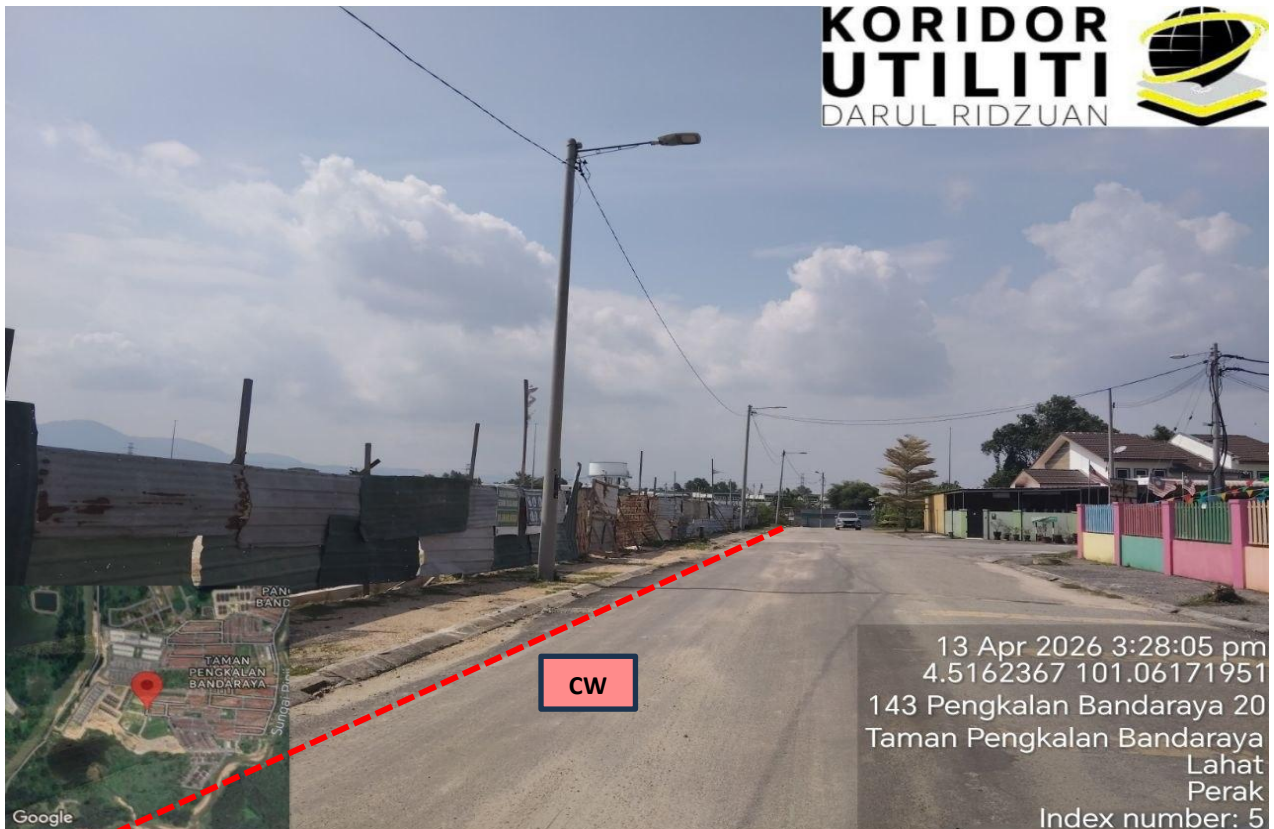
LOKASI KERJA KOREKAN TERBUKA DI PENGKALAN BANDARAYA 20
