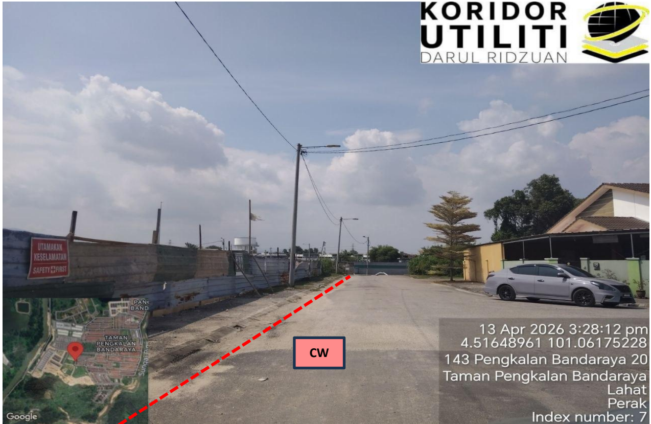
LOKASI KERJA KOREKAN TERBUKA DI PENGKALAN BANDARAYA 20
