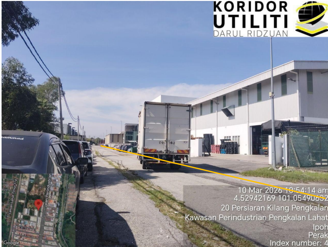
LOKASI DI JALAN PERSIARAN PERINDUSTRIAN PENGKALAN 24
