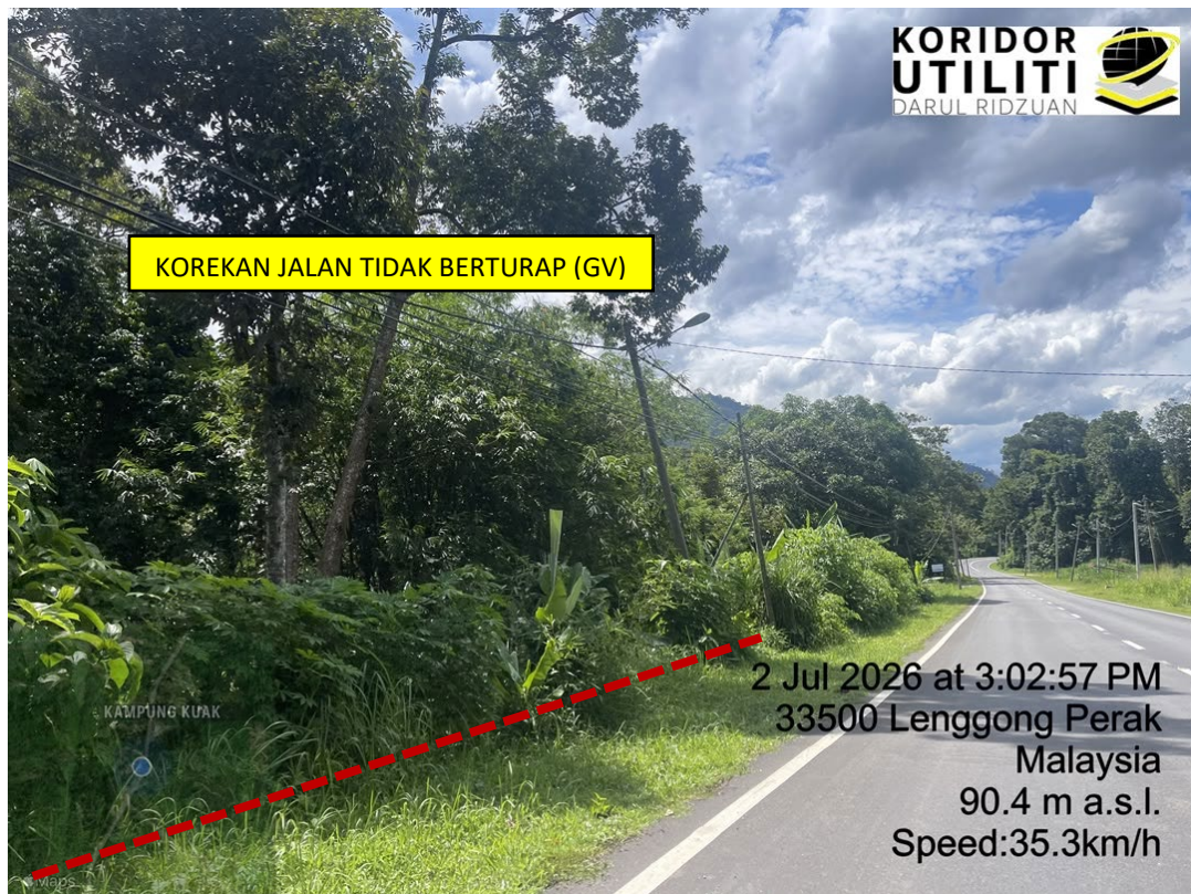
LOKASI DI JALAN LAMA SAUK - LENGGONG
