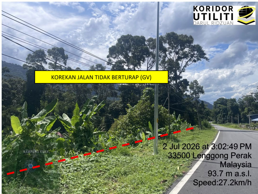
LOKASI DI JALAN LAMA SAUK - LENGGONG
