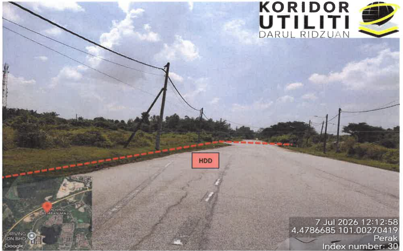
LOKASI KERJA-KERJA KOREKAN HDD DI DATARAN BEMBAN 20
