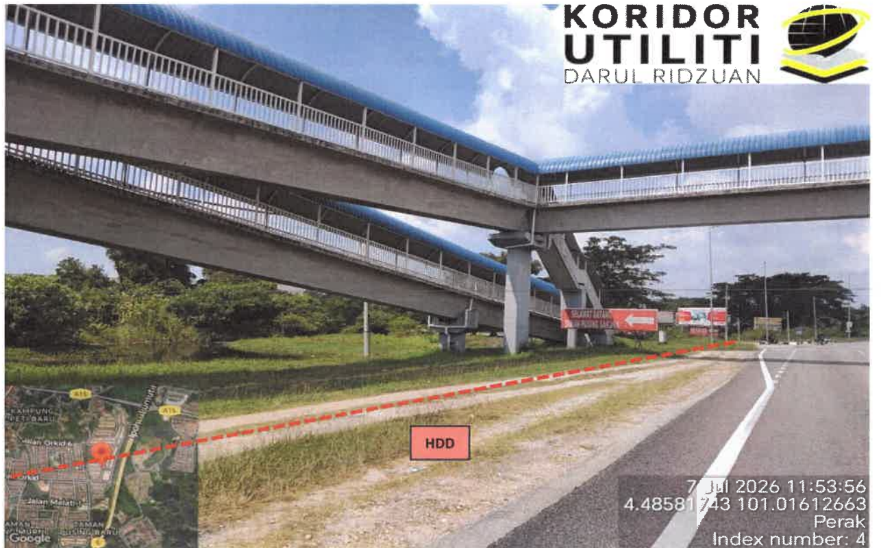
LOKASI KERJA-KERJA KOREKAN HDD DI IPOH-LUMUT HIGHWAY (FT5)
