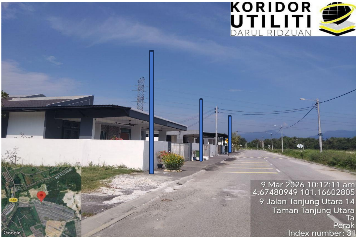
LOKASI KERJA PENANAMAN TIANG DI JALAN TANJUNG UTARA 15
