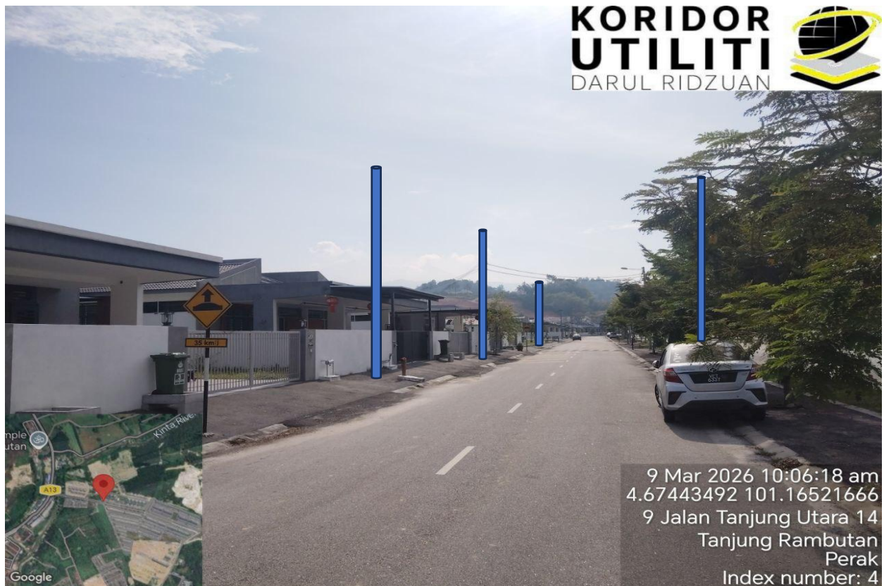
LOKASI KERJA PENANAMAN TIANG DI JALAN TANJUNG UTARA 14
