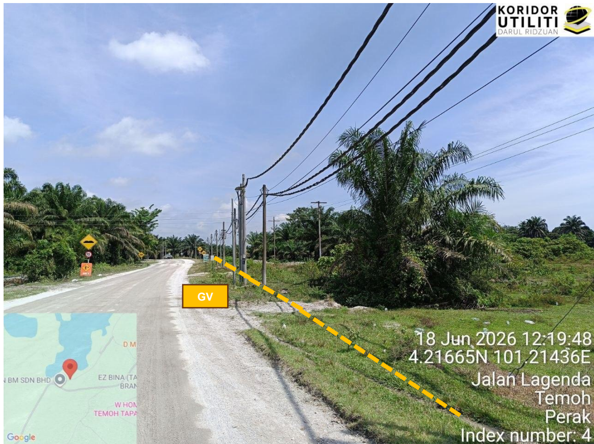
Rajah 3: Jalan Masuk Ke Kilang Lhoist, Chenderiang
