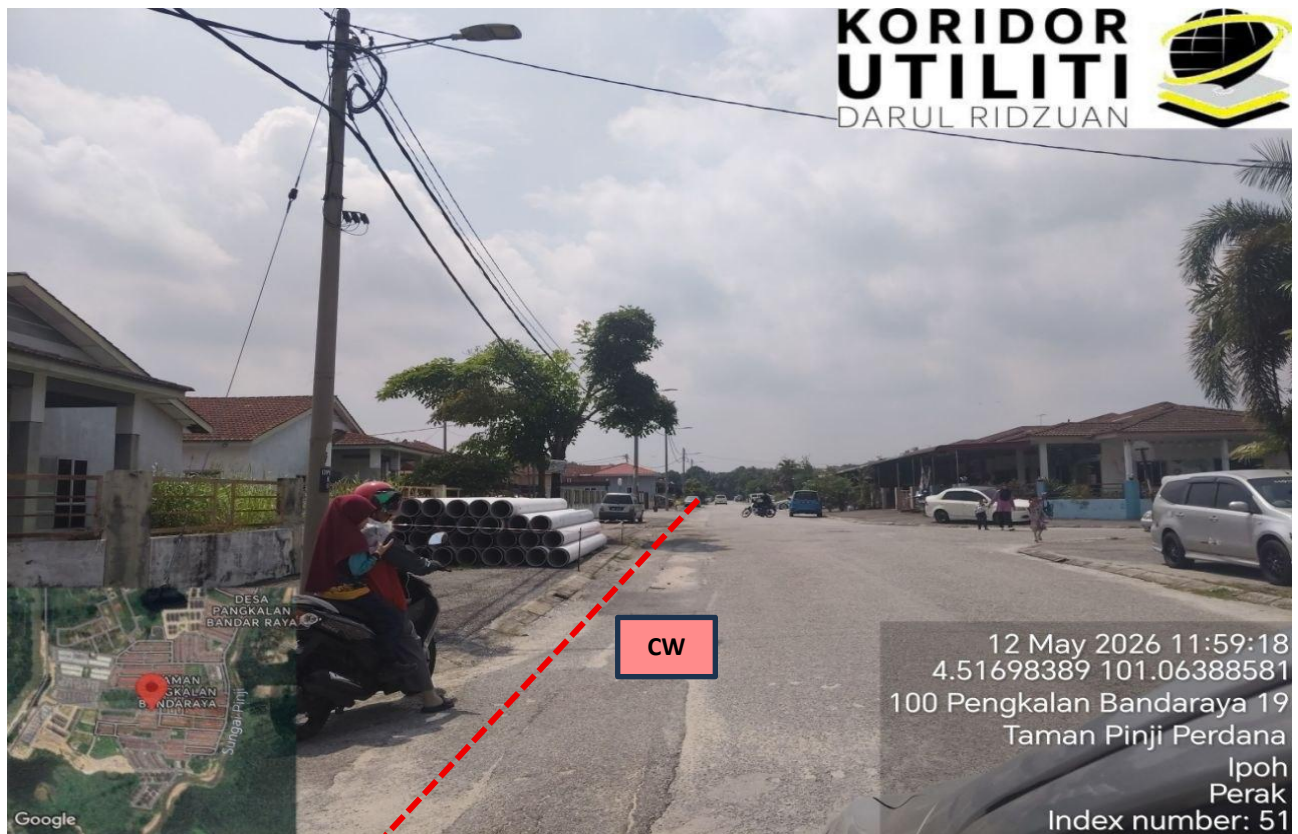
LOKASI KERJA KOREKAN TERBUKA DI PENGKALAN BANDARAYA 19
