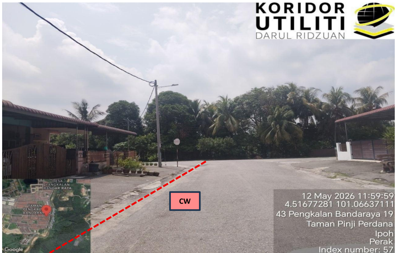
LOKASI KERJA KOREKAN TERBUKA DI PENGKALAN BANDARAYA 19
