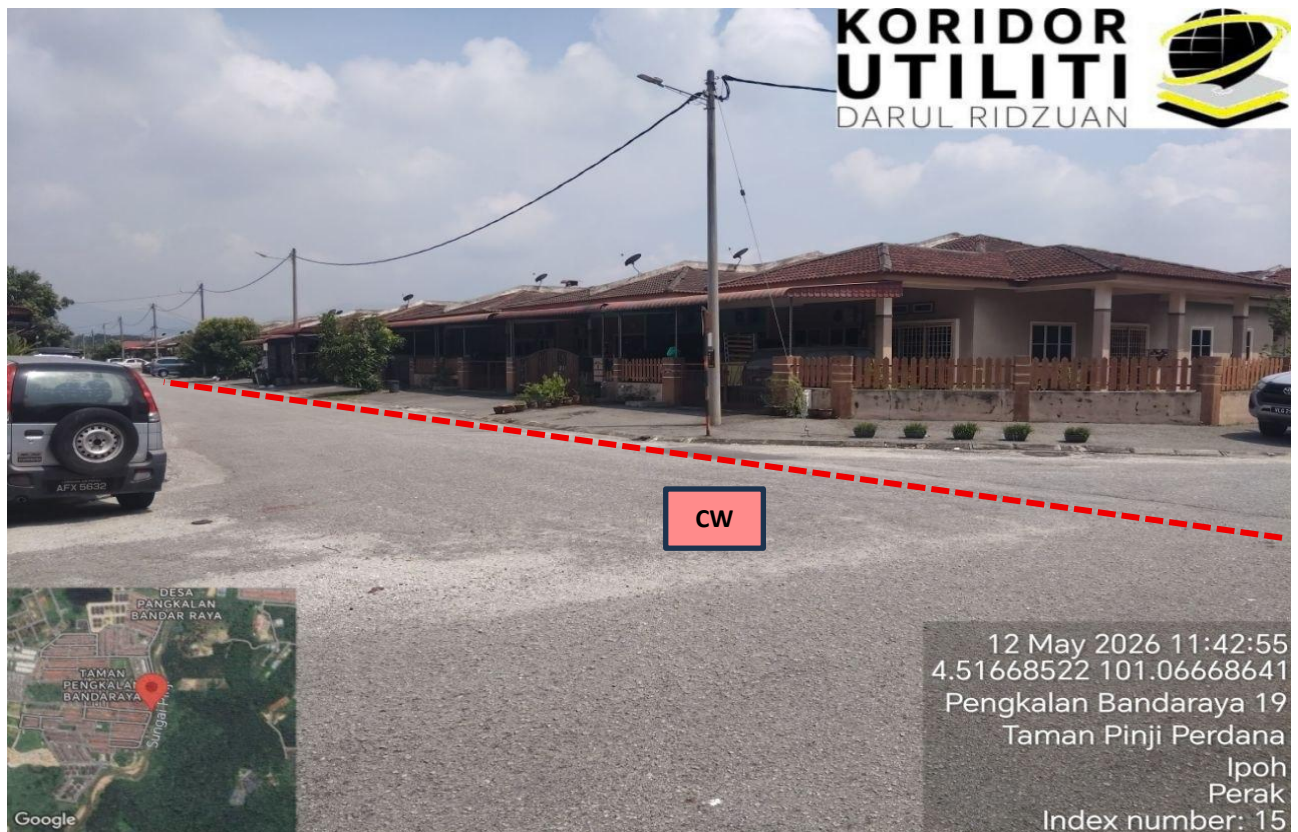
LOKASI KERJA KOREKAN TERBUKA DI PENGKALAN BANDARAYA 19
