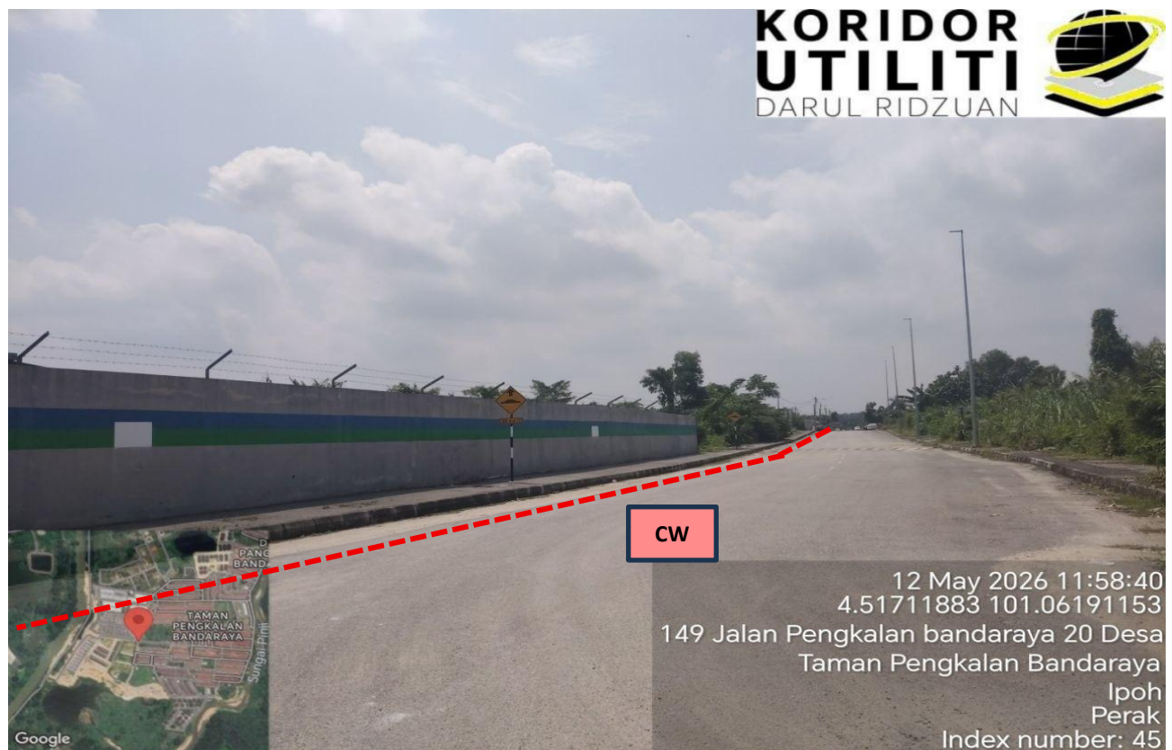
LOKASI KERJA KOREKAN TERBUKA DI PENGKALAN BANDARAYA 19
