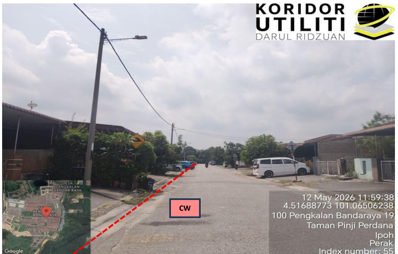
LOKASI KERJA KOREKAN TERBUKA DI PENGKALAN BANDARAYA 19
