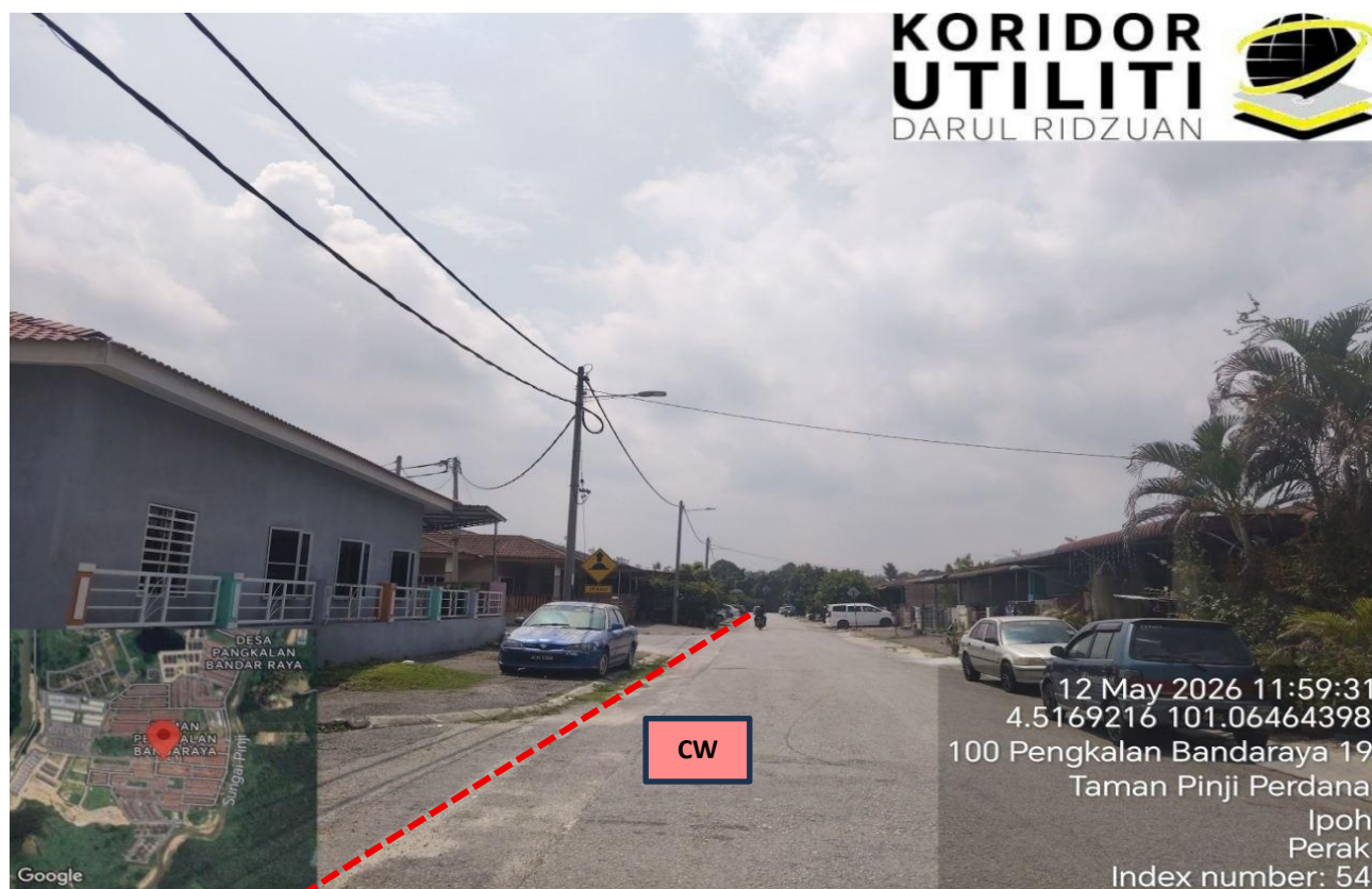
LOKASI KERJA KOREKAN TERBUKA DI PENGKALAN BANDARAYA 19
