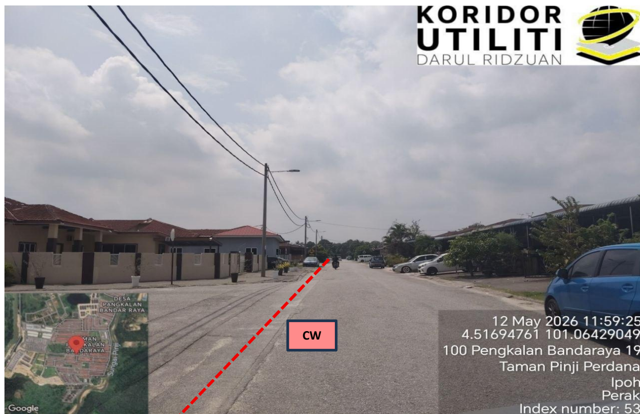
LOKASI KERJA KOREKAN TERBUKA DI PENGKALAN BANDARAYA 19
