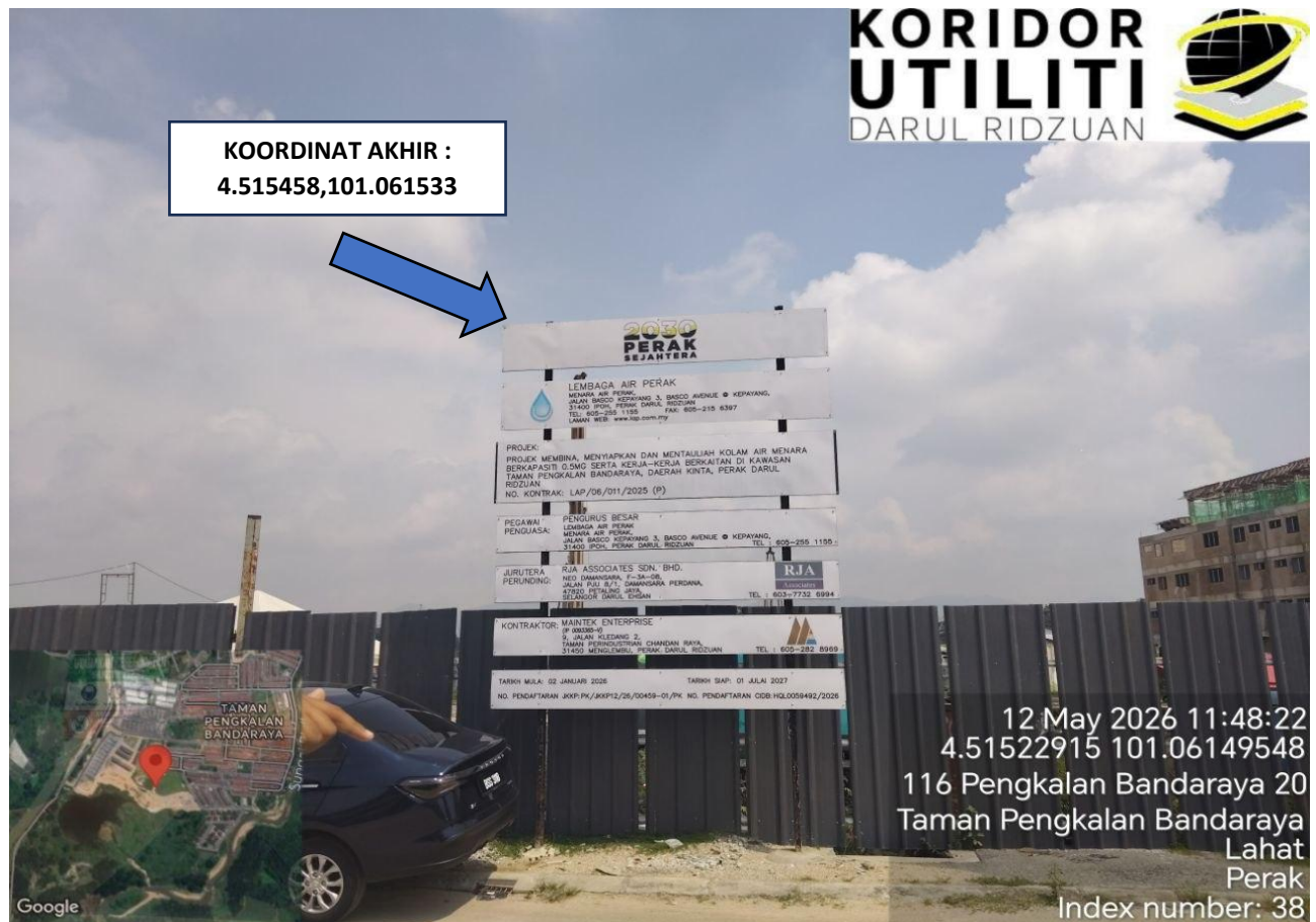
LOKASI KOORDINAT AKHIR TAPAK BINA DI JALAN TAMAN PENGKALAN BANDARAYA
