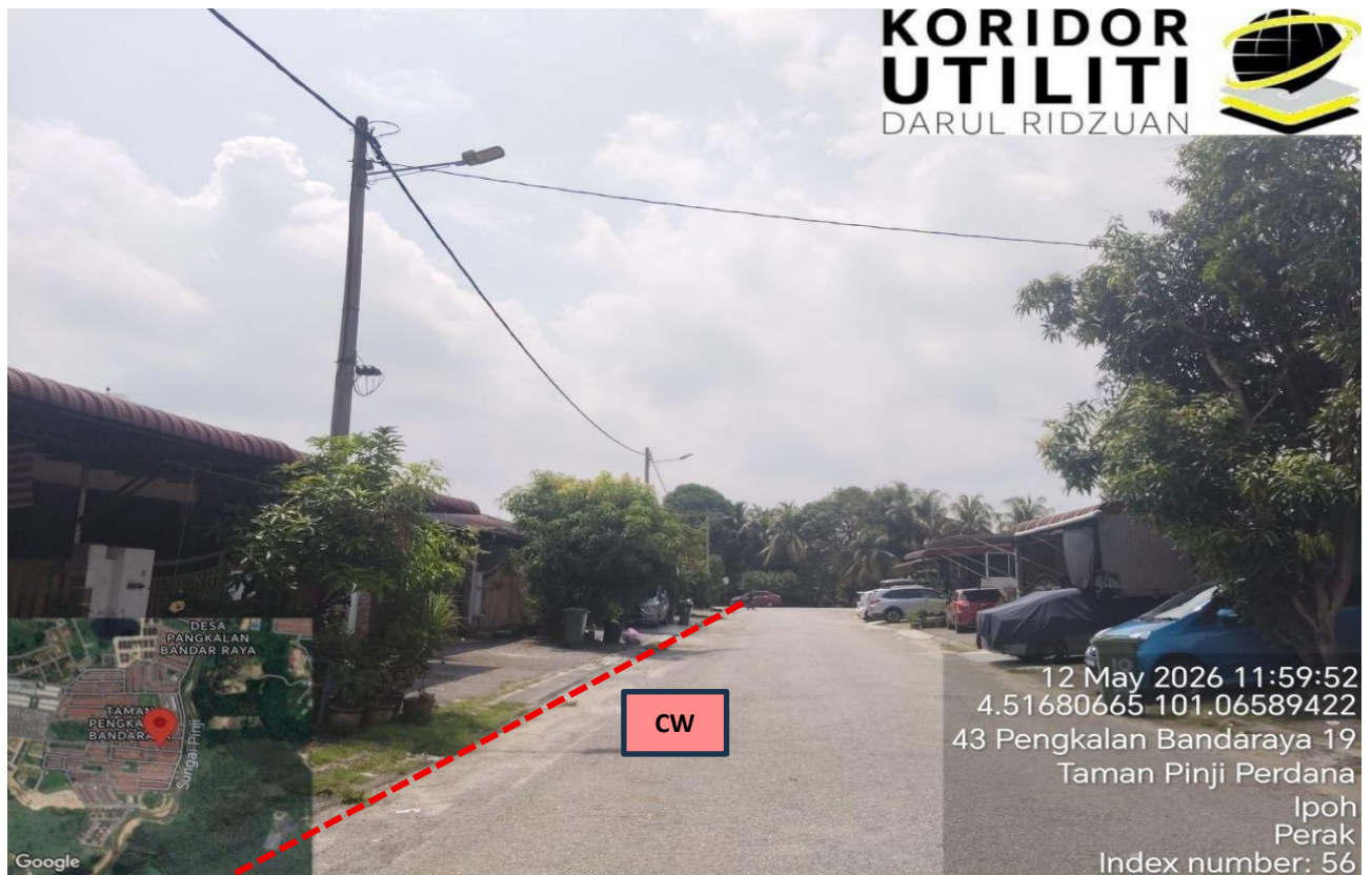
LOKASI KERJA KOREKAN TERBUKA DI PENGKALAN BANDARAYA 19
