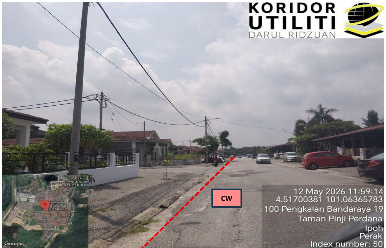
LOKASI KERJA KOREKAN TERBUKA DI PENGKALAN BANDARAYA 19
