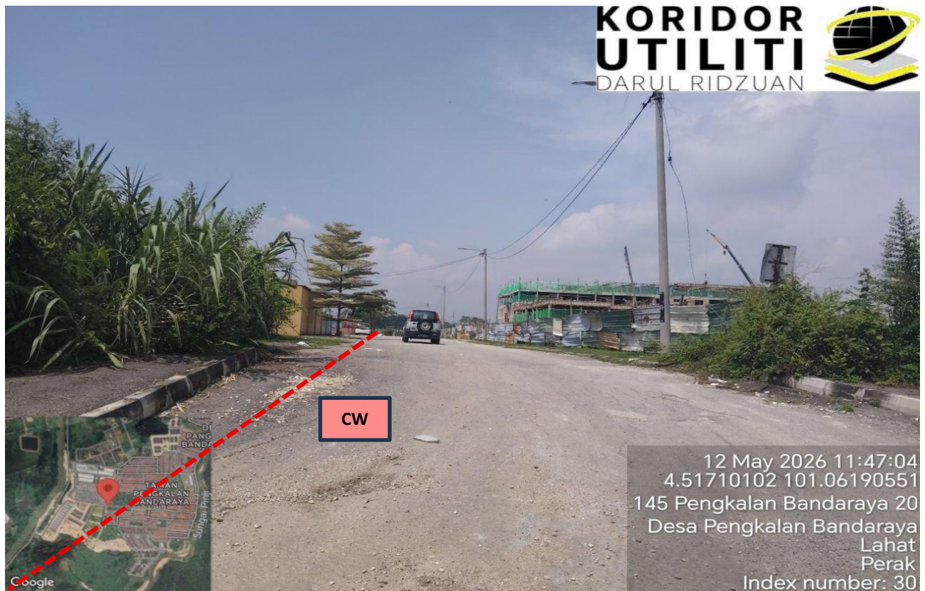
LOKASI KERJA KOREKAN TERBUKA DI JALAN TAMAN PENGKALAN BANDARAYA
