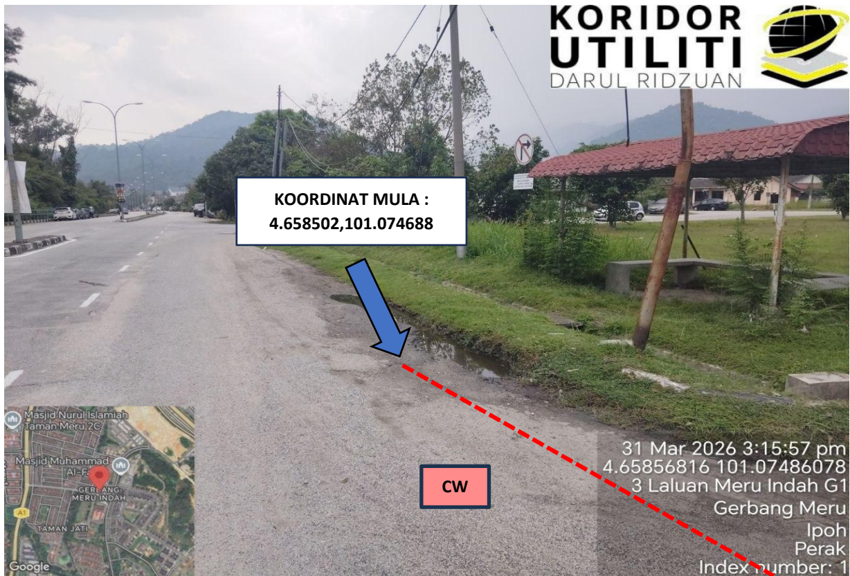
LOKASI KOORDINAT MULA KERJA KOREKAN TERBUKA DI JALAN TAMAN JATI
