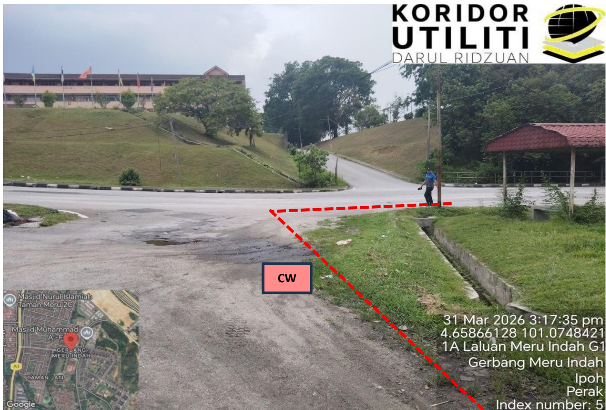
LOKASI KERJA KOREKAN TERBUKA DI LALUAN MERU INDAH G1
