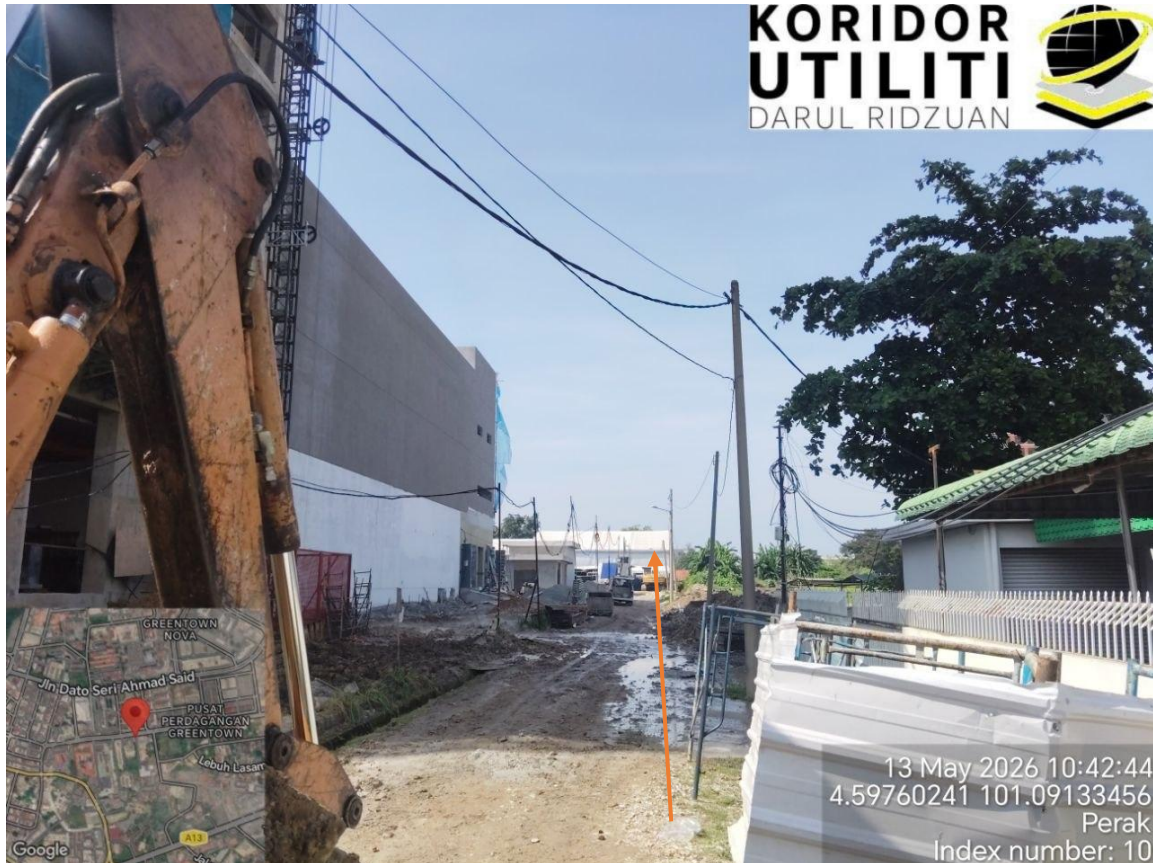
PENGALIHAN 7 BATANG TIANG TNB ANGGARAN -1 METER KE KIRI
