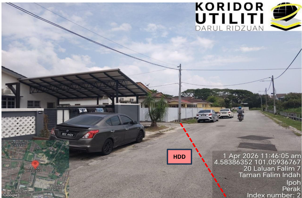
LOKASI KERJA KOREKAN HDD DI LALUAN FALIM
