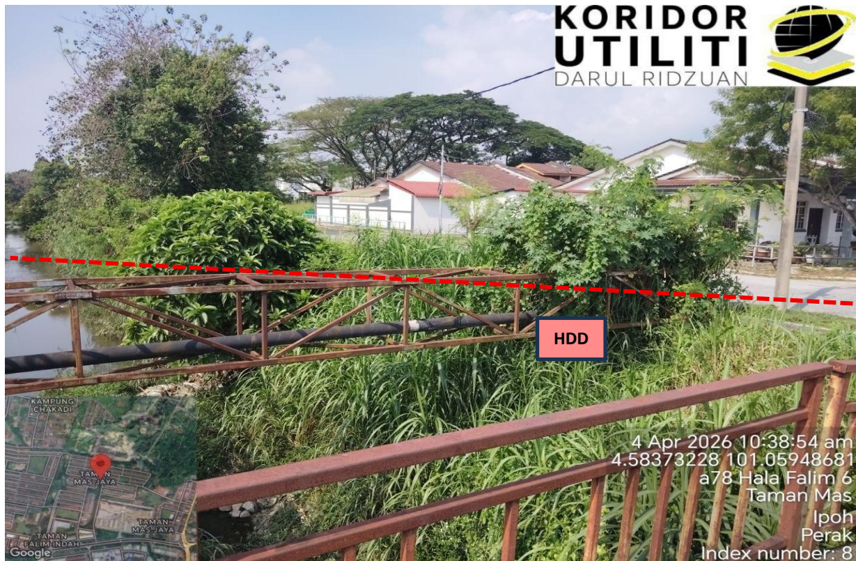
LOKASI KERJA KOREKAN HDD CROSSING DI SUNGAI PARI
