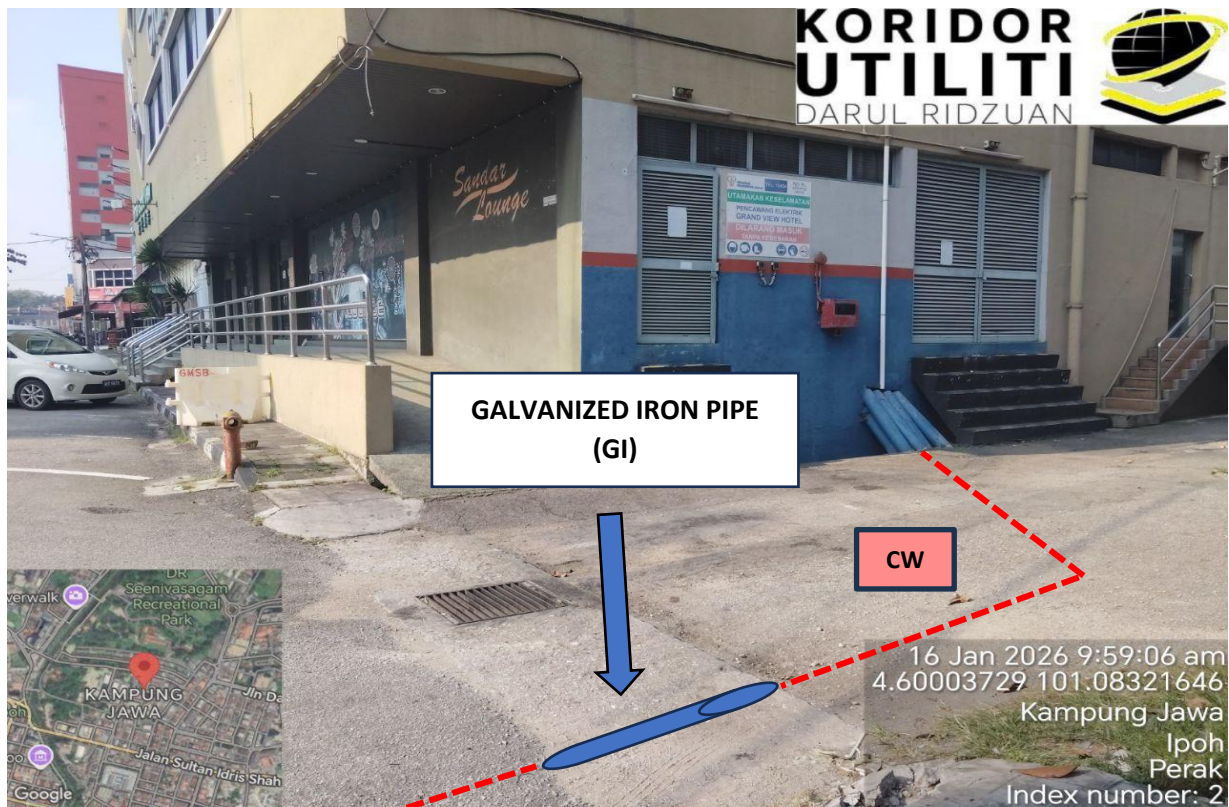
LOKASI KERJA KOREKAN TERBUKA DI JALAN HARLEY
