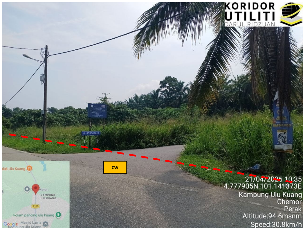
JAJARAN KOREKAN TERBUKA DI JALAN CHEMOR – ULU KUANG (A160)
