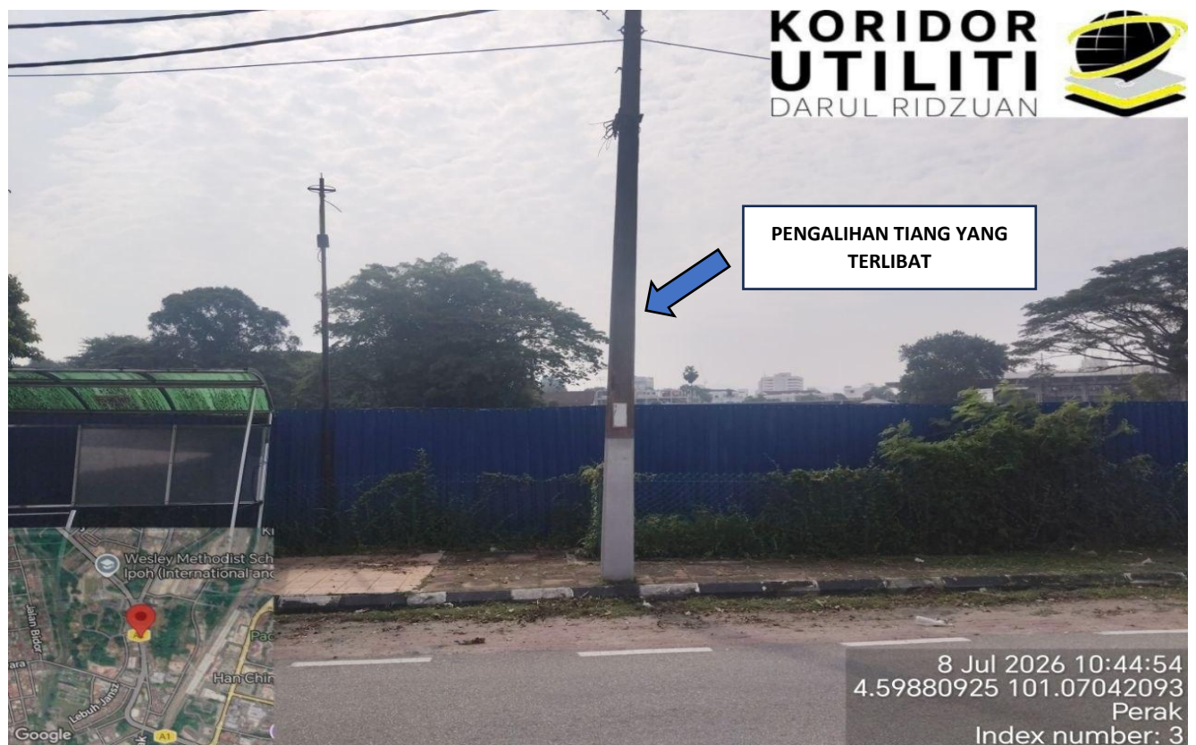
LOKASI KERJA PENGALIHAN TIANG DI JALAN TUN ABDUL RAZAK
