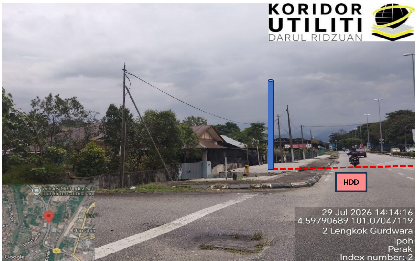
LOKASI KERJA KOREKAN HDD DAN PENANAMAN TIANG DI JALAN TUN ABDUL RAZAK
