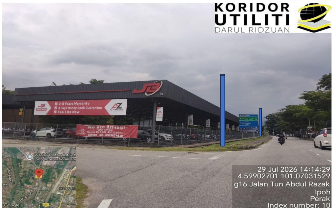
LOKASI KERJA PENANAMAN TIANG DI JALAN TUN ABDUL RAZAK
