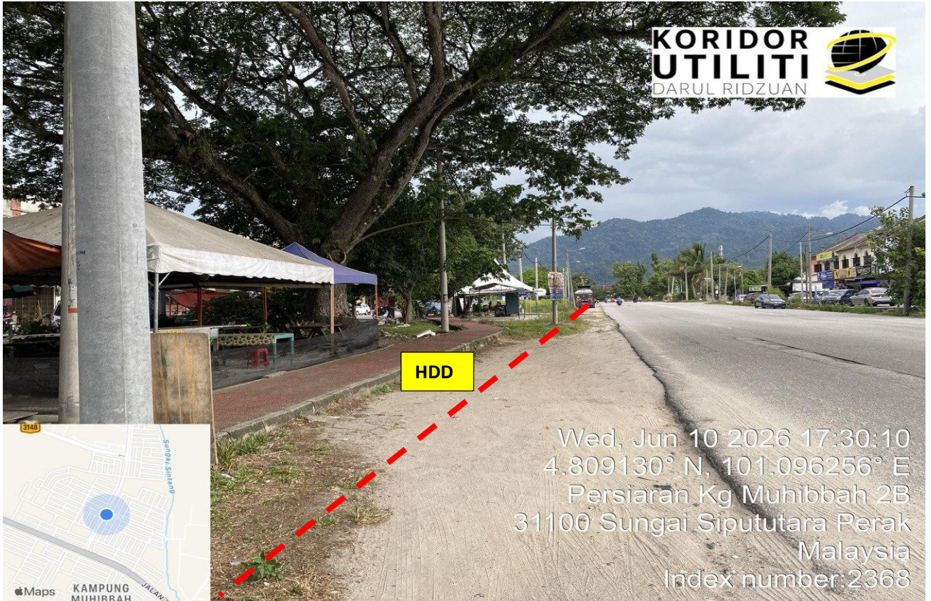
LOKASI DI JALAN INDUSTRI PERSIARAN MUHIBBAH 2B
