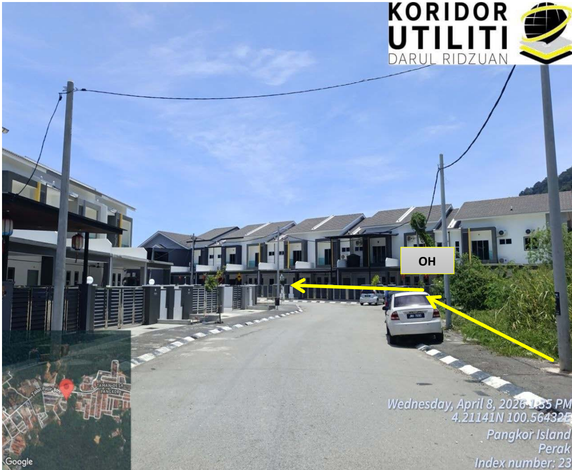
JAJARAN PEMASANGAN TIANG (OH) DI TAMAN PANGKOR MUTIARA (MPM)
