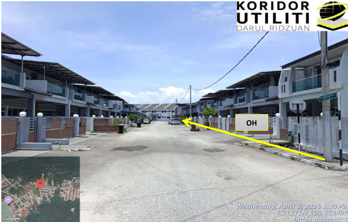
JAJARAN PEMASANGAN TIANG (OH) DI TAMAN PANGKOR MUTIARA (MPM)
