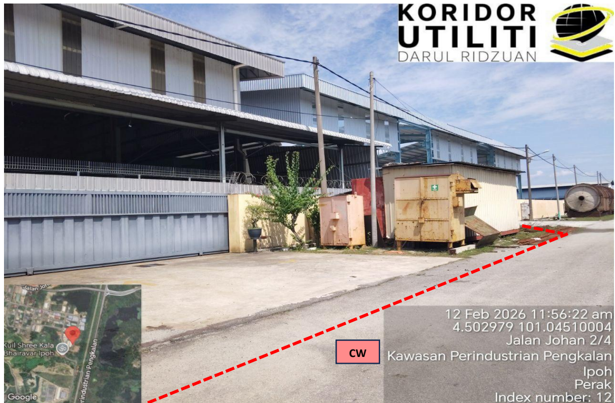
LOKASI KERJA-KERJA KOREKAN TERBUKA DI JALAN JOHAN 2/4
