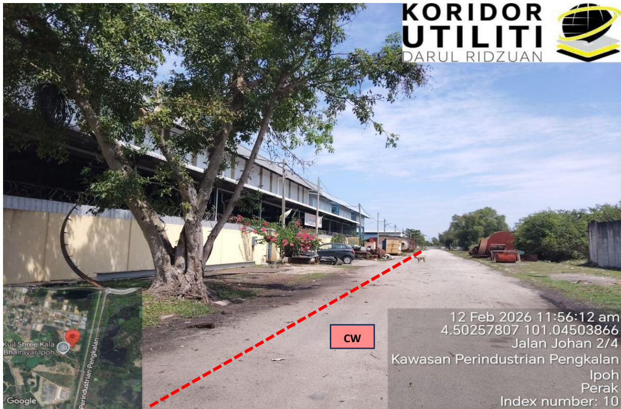
LOKASI KERJA-KERJA KOREKAN TERBUKA DI JALAN JOHAN 2/4
