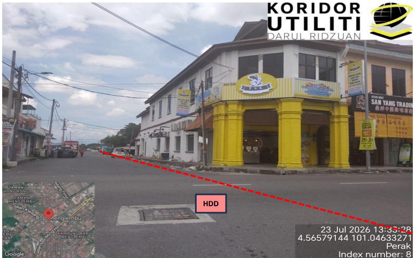
LOKASI KERJA KOREKAN HDD DI JALAN BESAR (LORONG TENGAH)
