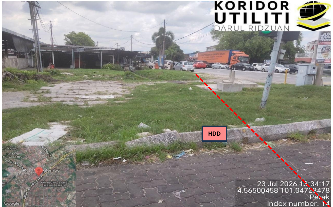
LOKASI KERJA KOREKAN HDD DI JALAN LEE MING HIN (LORONG TENGAH)
