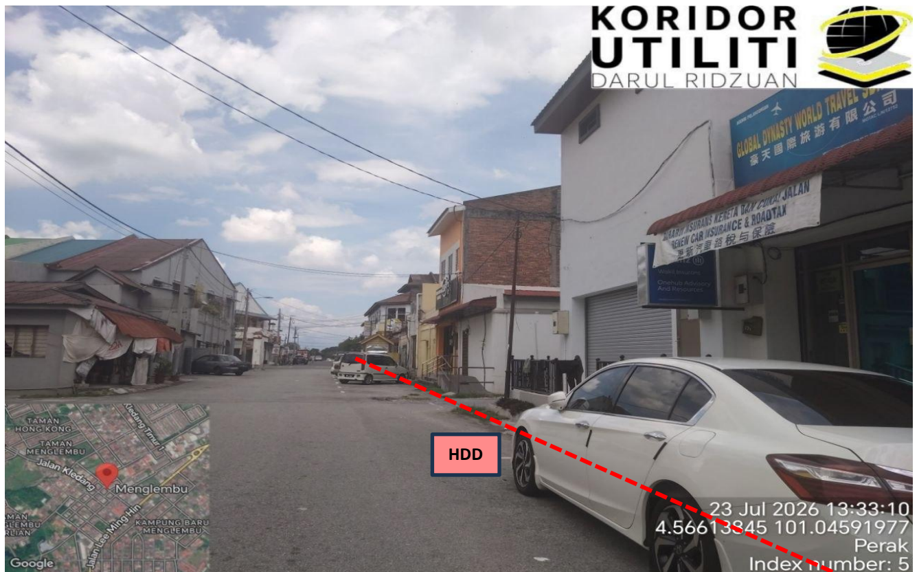
LOKASI KERJA KOREKAN HDD DI JALAN TRANCHELL (LORONG TENGAH)
