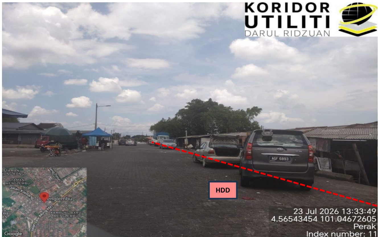
LOKASI KERJA KOREKAN HDD DI JALAN LEE MING HIN (LORONG TENGAH)
