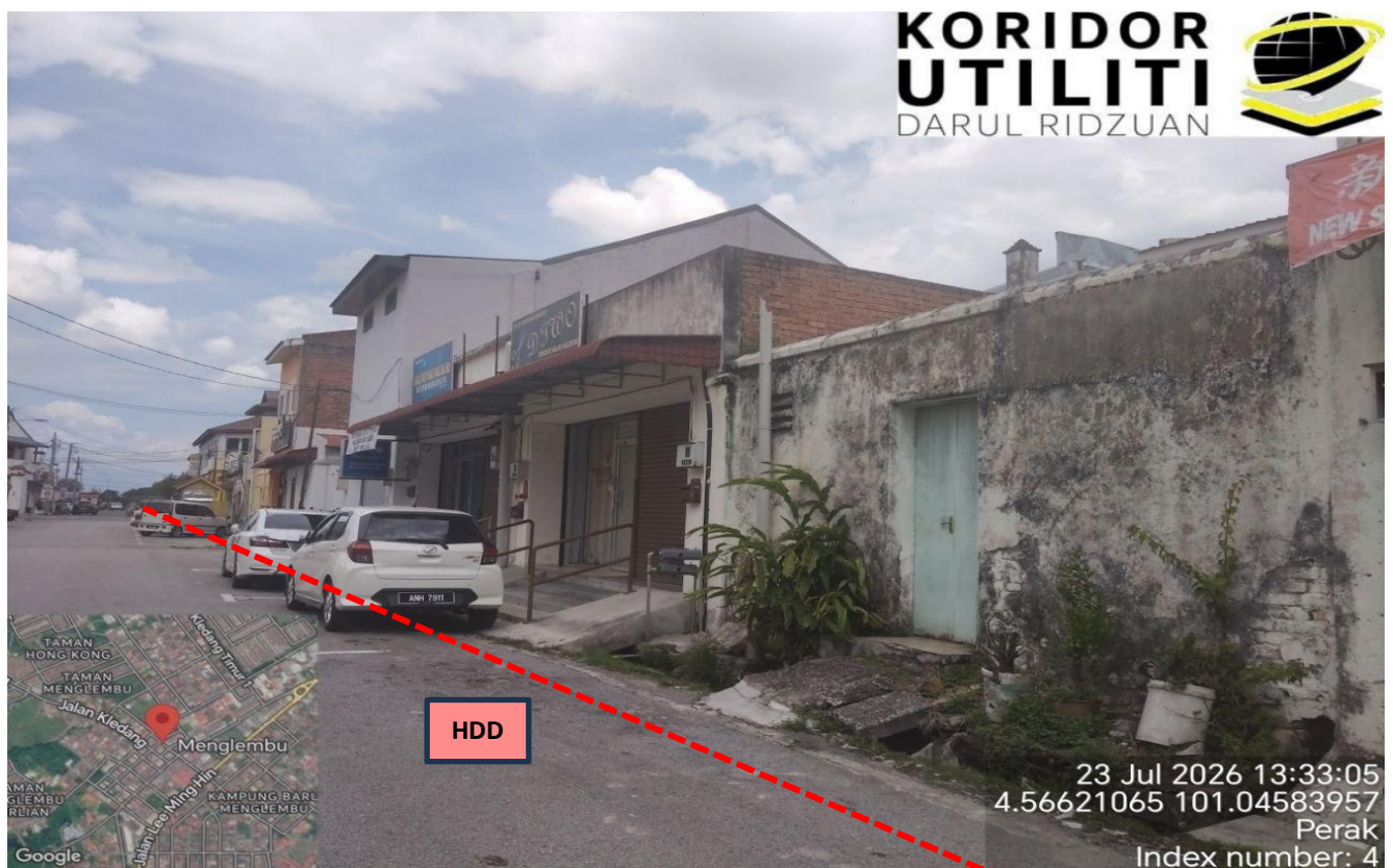
LOKASI KERJA KOREKAN HDD DI JALAN TRANCHELL (LORONG TENGAH)
