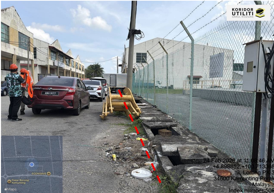
CADANGAN LALUAN OPEN CUT DI JALAN BERTURAP
